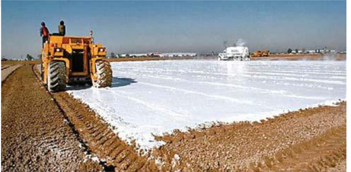
Şekil 2.12. Kireç ile iyileştirme (Briaud 2013)
