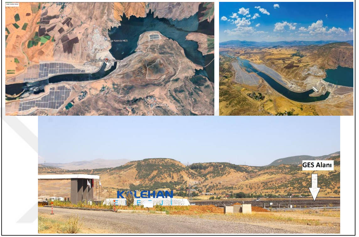
Fotoğraf 5.1. Aşağı Kaleköy Barajının GES ve HES Alanlarından Bir Görünüm.
