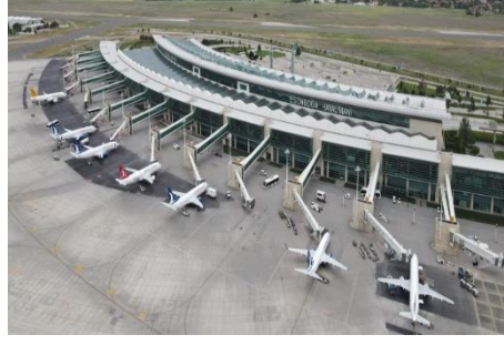
Şekil 2. Ankara Esenboğa Havalimanı hava fotoğrafı (DHMİ, t.y.-a)
