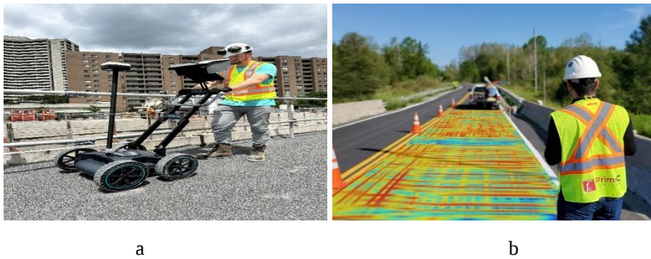
Şekil 34. GPR uygulaması örneği (FPrimeC, t.y.)
