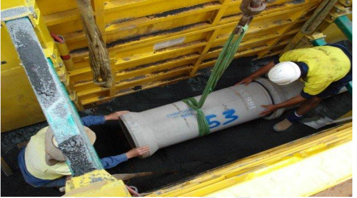
Şekil 9. Kanalizasyona geopolimer malzemeden üretilen beton borular yerleştirilirken (Toowoomba, Queensland, Avustralya)
