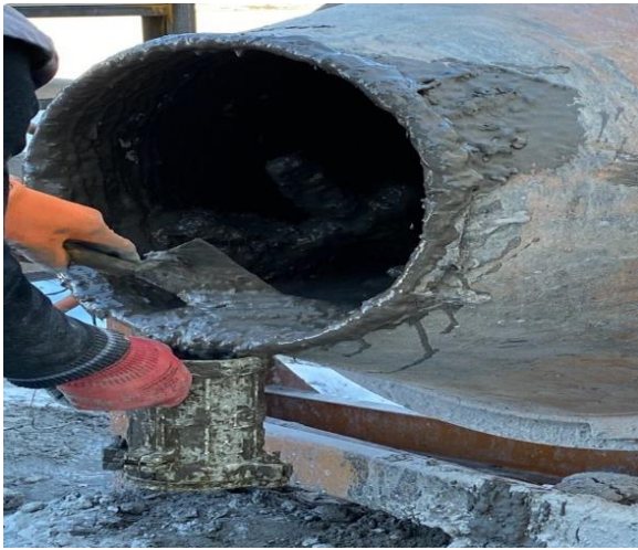
Şekil 32. (a) Yüksek kiriş dökümü ve (b) numune alımı
