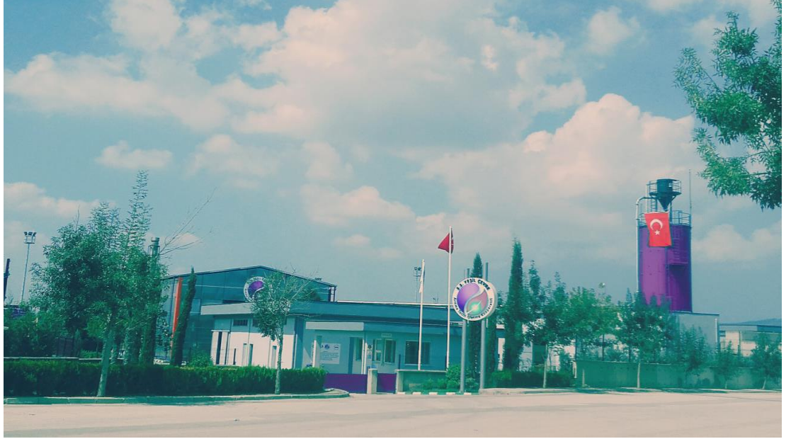
Fotoğraf 3.9. Zafer Mahallesi Zafer Caddesi üzerinde yer alan Yeşil Çevre Arıtma Tesisi
