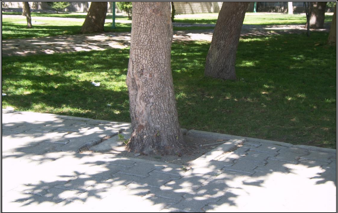
Şekil 4.64. Ağaçlar kök boğazına kadar asfaltlanmakta, kök yayılma alanı daralmaktadır (Orijinal 2009).
