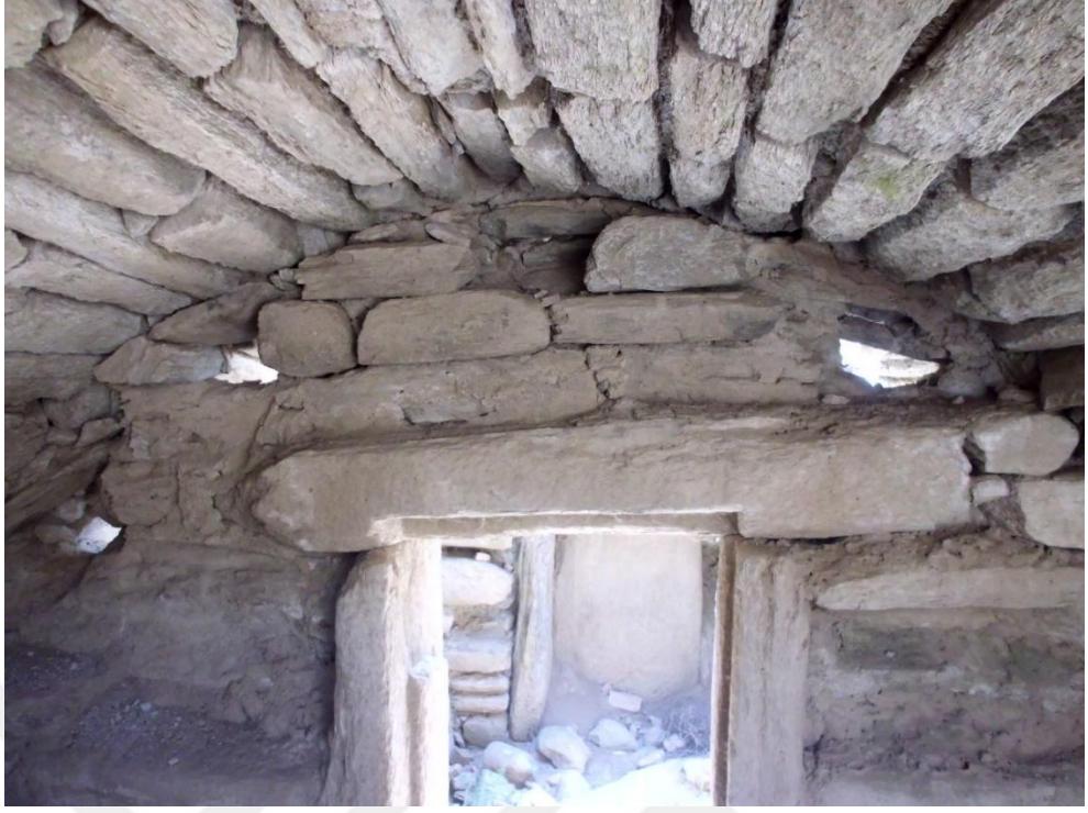
Resim 21. 2 Nolu Oda Mezar-Duvar yapısı ve tonozlu üst yapısı
