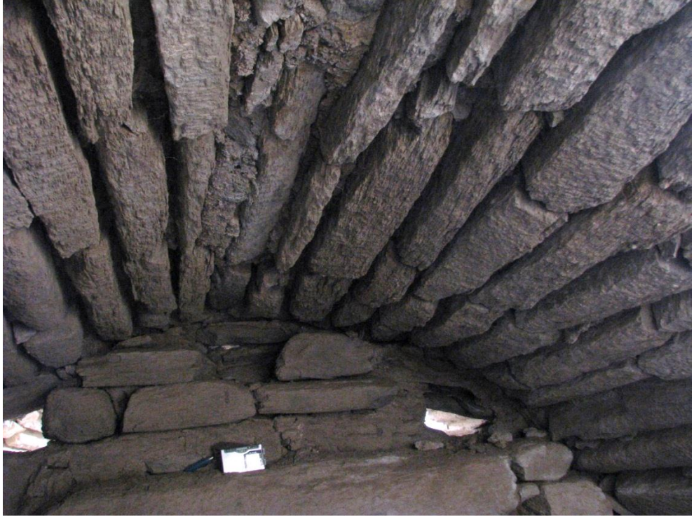
Resim 22. 2 Nolu Oda Mezar-Duvar yapısı ve tonozlu üst yapısı
