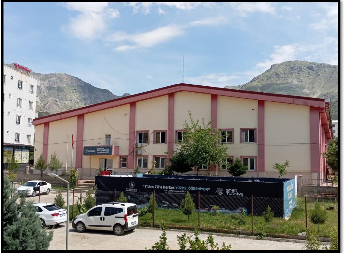
Fotoğraf 2.9. Kasabada hizmet veren Gençlik ve Spor İlçe Müdürlüğü Binasından Bir Görünüm.
