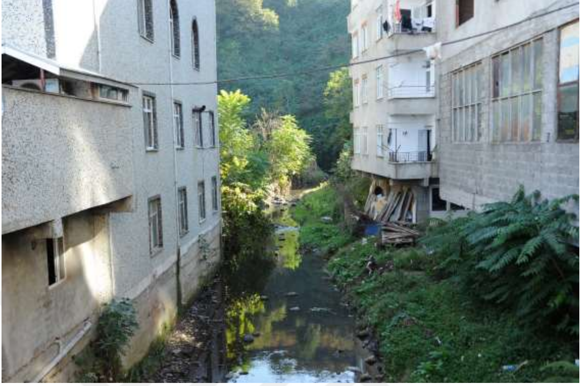
Fotoğraf 2.18. Görele Şehrinde Planlama Eksikliği Nedeniyle Dere Yataklarının Yapılaşmaya Açılmış Olmasına Bir Örnek. Kaba Mahallesinde Aynı Adı Taşıyan Dere Yatağında İnşa Edilmiş Evler
