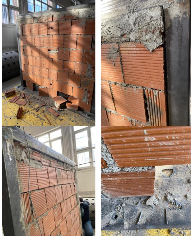
Şekil 83. Düzlem dışı durumda RBGBH modelinde oluşan hasarlar
