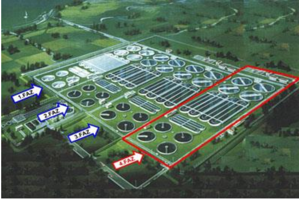
Şekil 3.8. Çiğli atıksu arıtma tesisi (Anonim 2013c)
