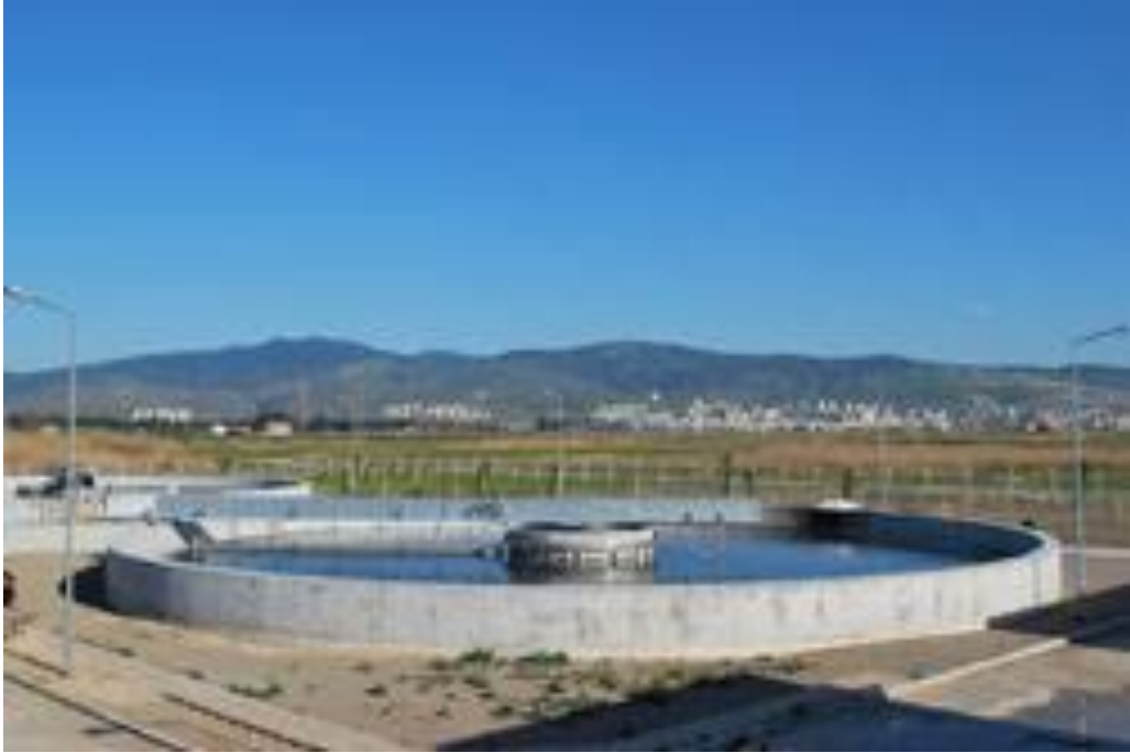
Şekil 3.7. Menemen atıksu arıtma tesisi (Anonim 2013c)
