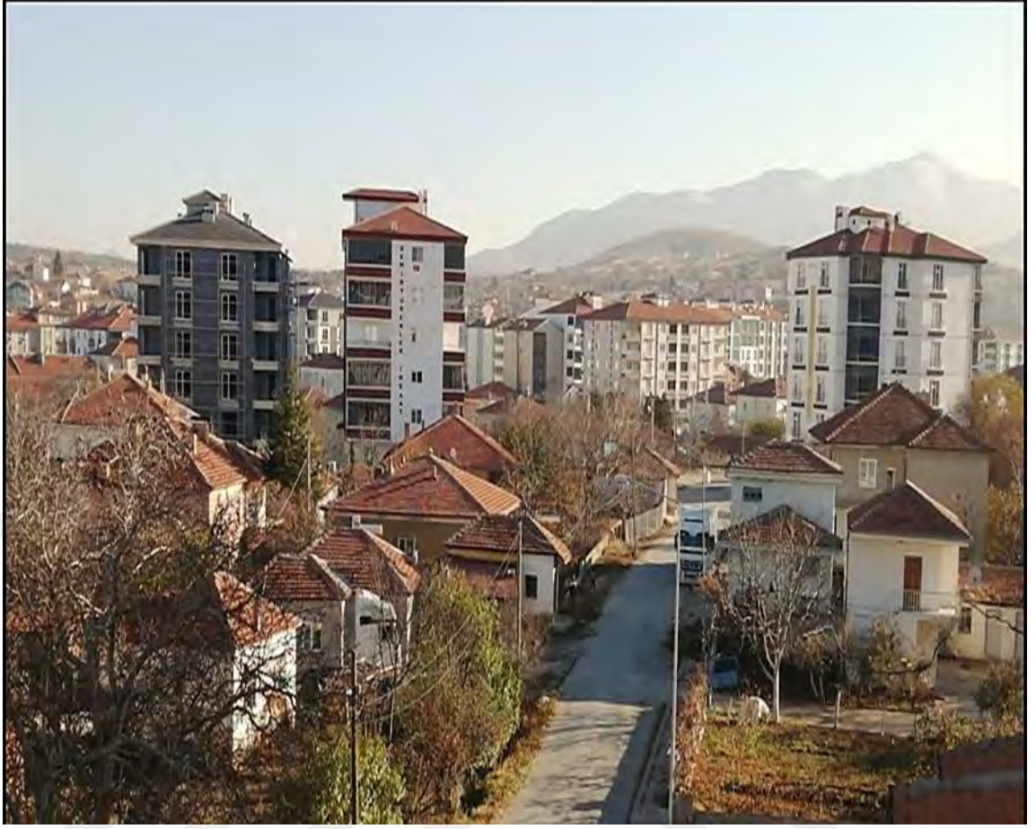
Fotoğraf 2.6. Fatih Mahallesi'nde Yer Alan Müstakil ve Çok Katlı Binalardan Bir Görünüm.
