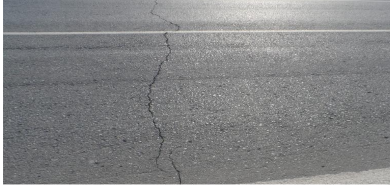
Şekil 6. Enine Çatlak (Asfalt 2002; Alkasah 2020).
