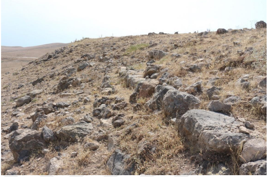
Fotoğraf 30: Alaköy Kalesinde tespit edilen mimari temeller (güney cephe)
