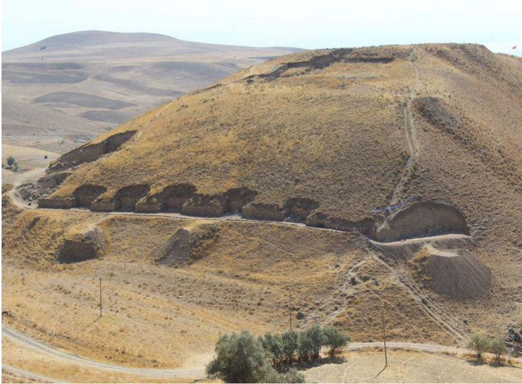
Fotoğraf 10: Sur duvarlarının genel görüntüsü
