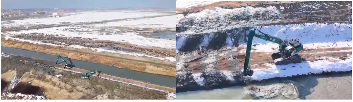
Şekil 6. Nörkah ana tahliye kanalı temizliği (DSİ Genel Müdürlüğü)
