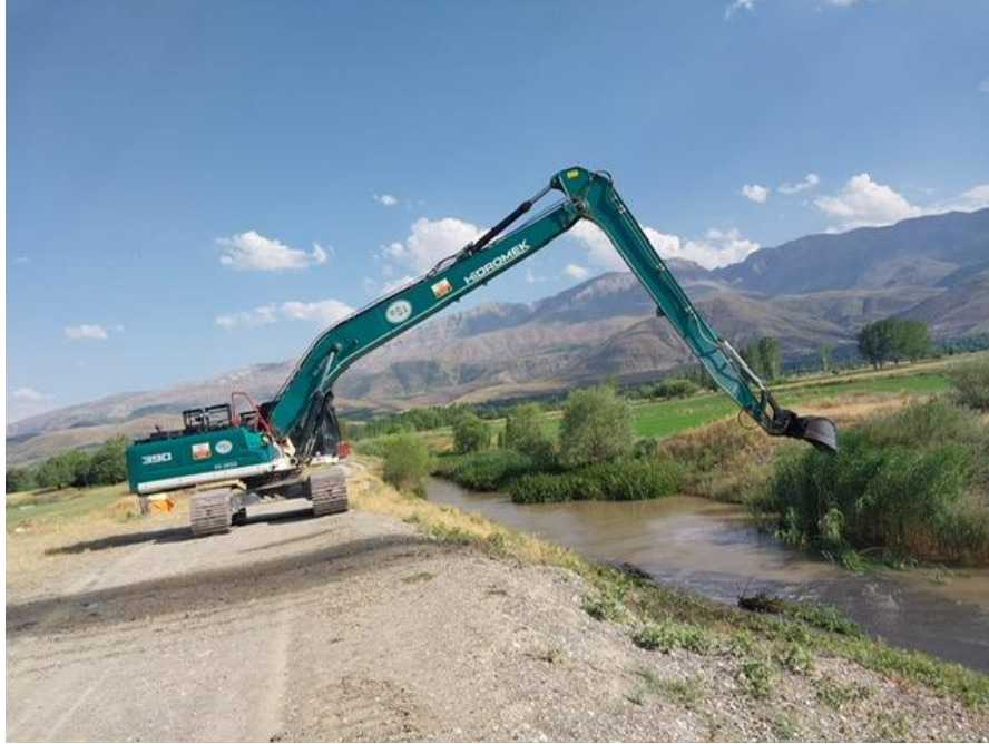
Şekil 5. Sol sahil ana tahliye kanalı temizliği (Özgün, Şeyma ÖZGENEL)
