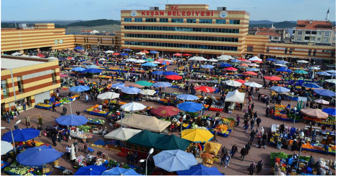
Fotoğraf 3.3. Belediye Kompleksinde Kurulan Cumartesi Pazarı'ndan Bir Görünüm.
