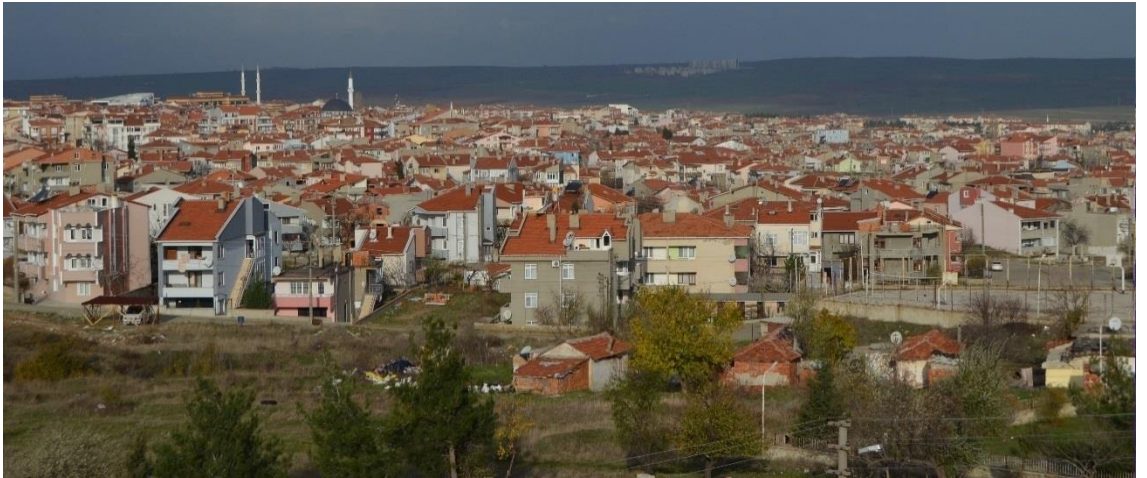
Fotoğraf 2.9. Keşan’da İnşa Edilen İki ve Üç Katlı Konutlardan Bir Görünüm.
