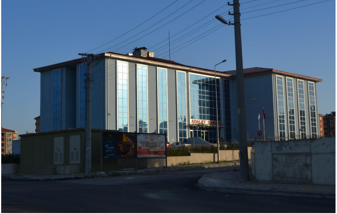
Fotoğraf 3.1. Yeni Mahalle'de Hizmet Veren Keşan Adliyesinden Bir Görünüm
