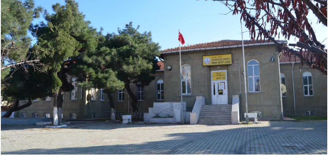
Fotoğraf 3.12. Keşan Kent Müzesine Dönüştürülen Eski Askerî Hastane Binası.
