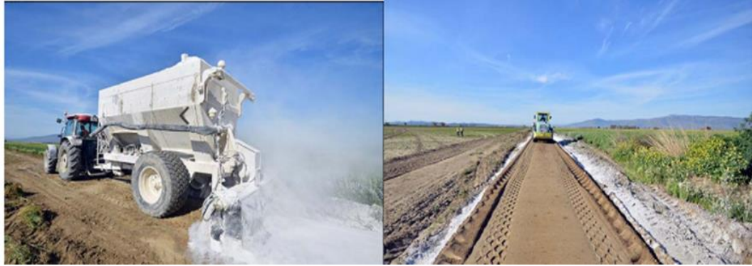
Şekil 5. Kireç ile iyileştirme yönteminin yol yapımında uygulanması (Şahbaz 2020)
