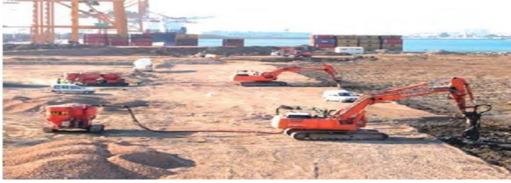
Şekil 6. Çimento ile karıştırma yönteminin kullanıldığı alan (Burgos vd 2007)
