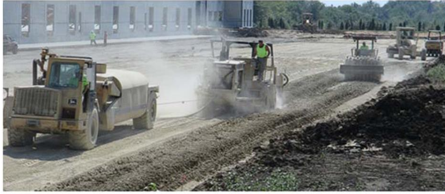
Şekil 4. Uçucu kül ile zemin iyileştirmesi (Çetinkaya 2012)
