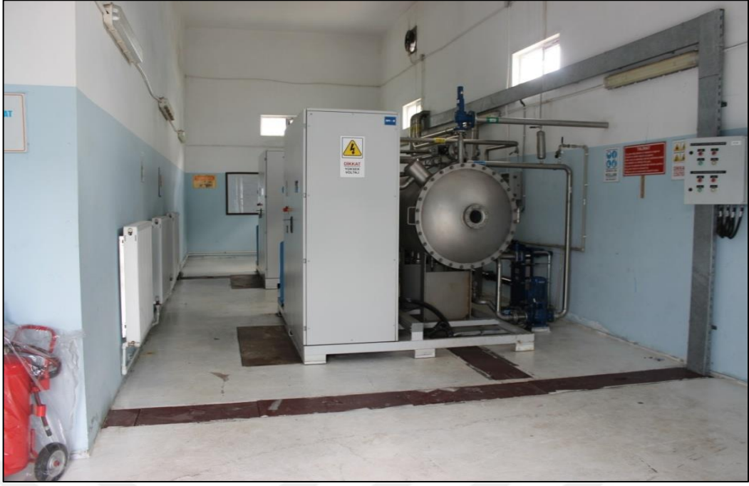
Şekil 9. İçme suyu arıtma tesisine ait örnek ozonlama ünitesi
