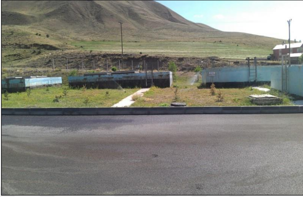
Şekil 7. İçme suyu arıtma tesislerine ait örnek giriş yapısı
