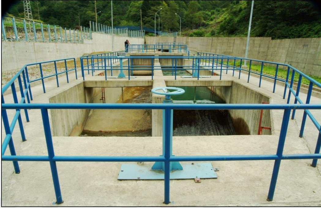
Şekil 6. İçme suyu arıtma tesislerine ait örnek su alma yapısı
