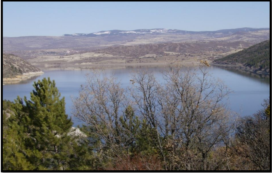
Fotoğraf 1.8. Barajın Mesire Yerinden Kurtboğazi Barajı Görüntüsü.
