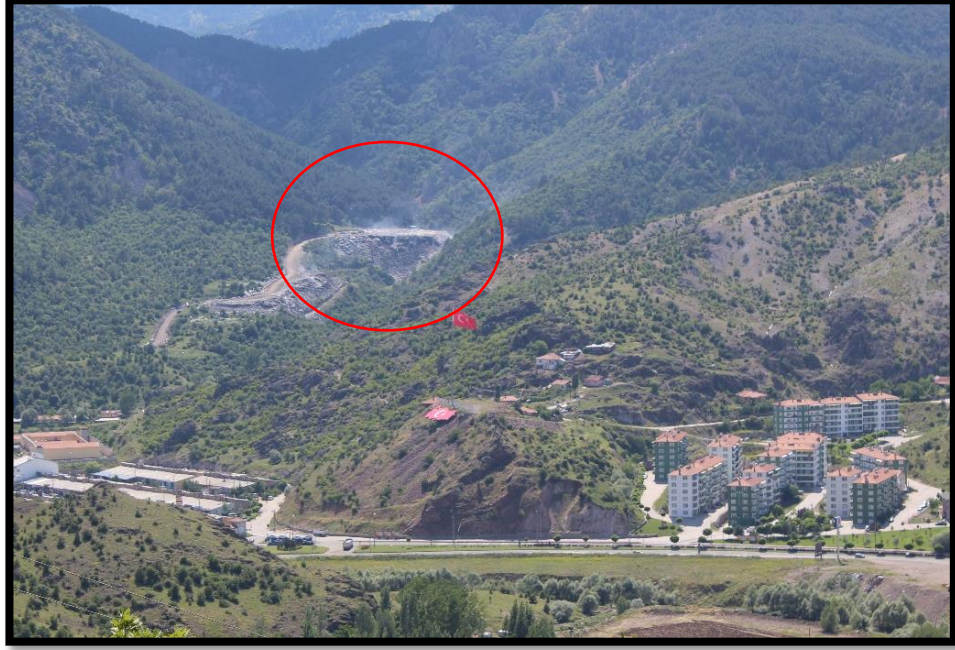
Fotoğraf 5.6. İlçe Merkezine Çok Yakın Bir Konumda Bulunan Çöp Depolama Alanı Ankara-Kızılcahamam Yolunun Batısında Bulunmaktadır.
