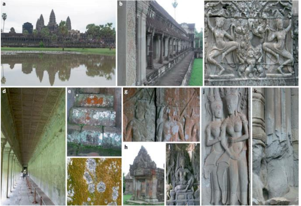
Şekil 1. Biyodeteriorasyona Maruz Kalmış Bazı Tarihi Yapılar (Liu et al. 2020)
