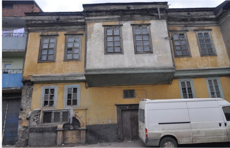
Şekil 41. Yeğenağa Sokak’ın cephe düzenlemesi yapılan Korucular Evi uygulama öncesi (Arşiv 1)
