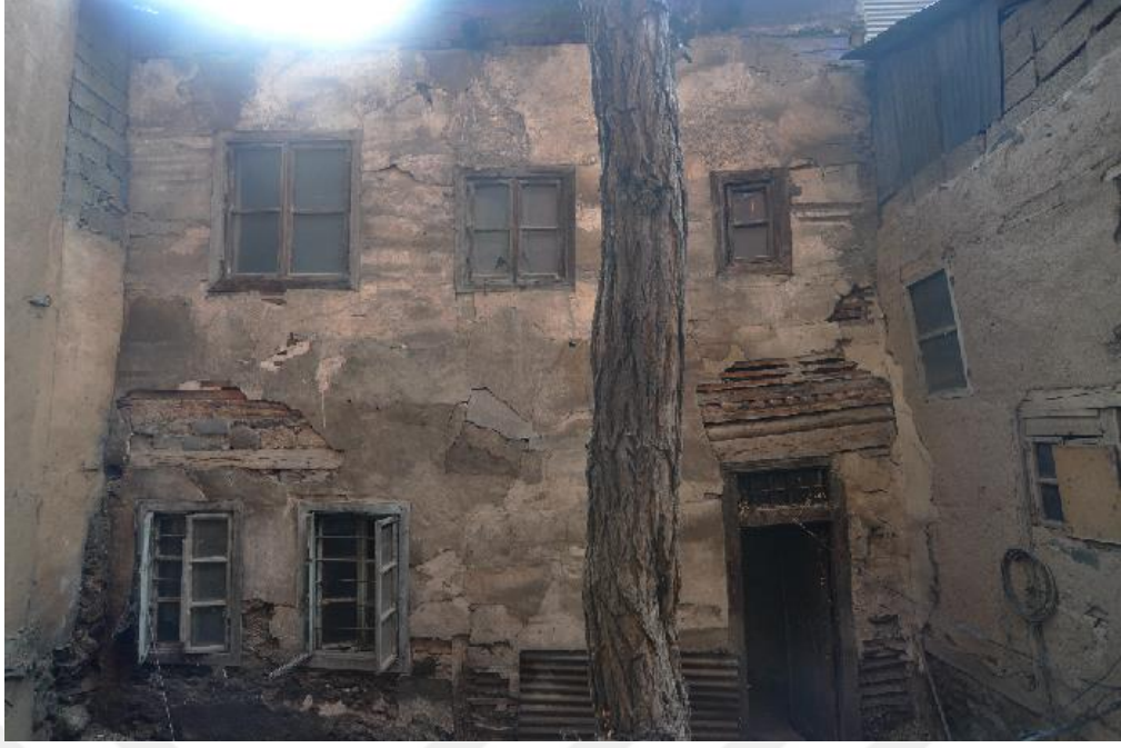
Şekil 49. Yeğenağa Sokak’ın cephe düzenlemesi yapılan yapı 4 uygulama öncesi avlu görünüşü (Arşiv 1)
