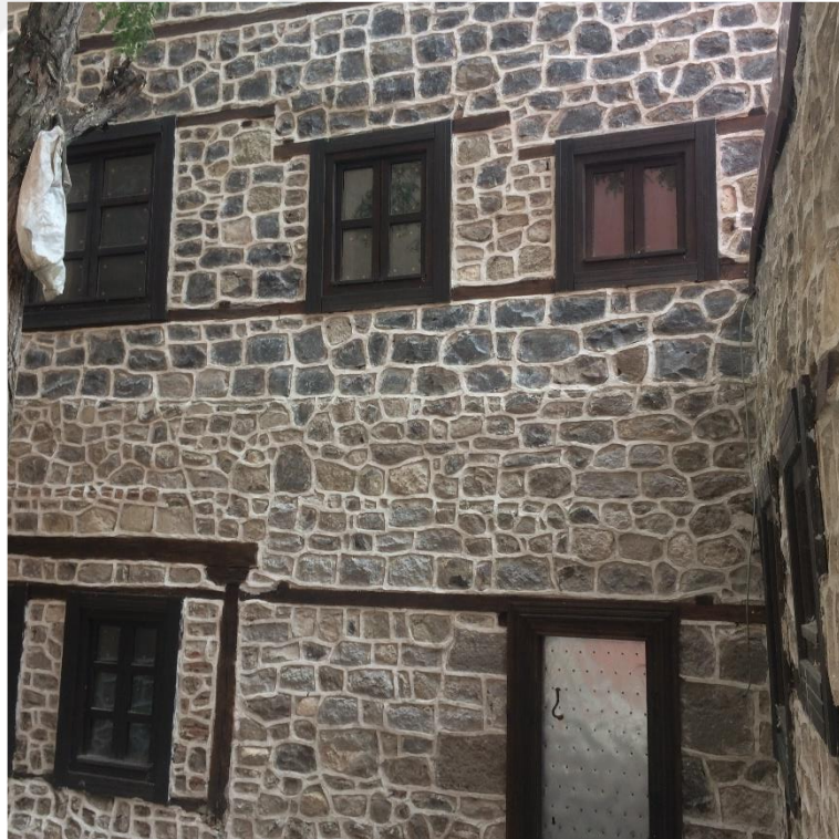
Şekil 52. Yeğenağa Sokak'ın cephe düzenlemesi yapılan yapı 4 uygulama sonrası avlu görünüşü (Arşiv 3)
