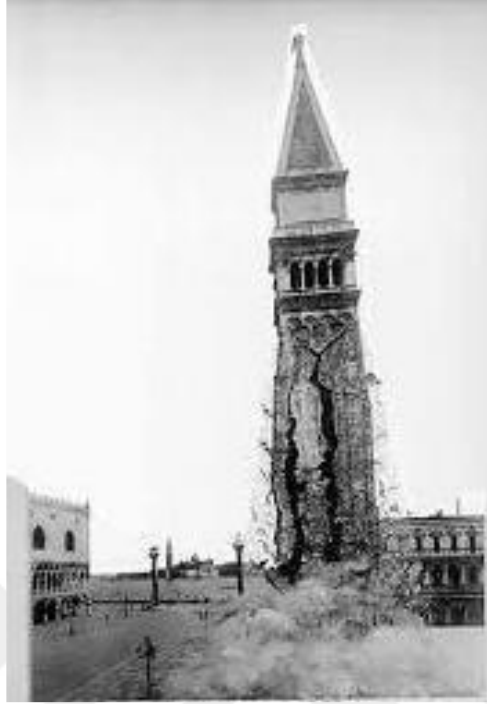
Şekil 13. Venedik - San Marco Çan Kulesi (yeniden yapılanma öncesi) (Körlü 2015)
