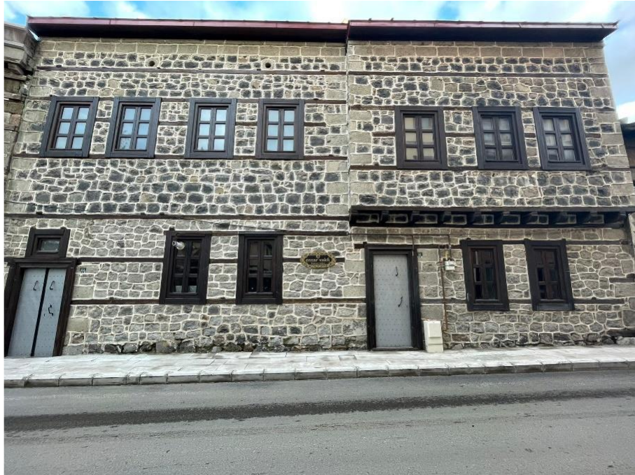
Şekil 50. Yeğenağa Sokak’ın cephe düzenlemesi yapılan yapı 4 uygulama sonrası (Arşiv 3)
