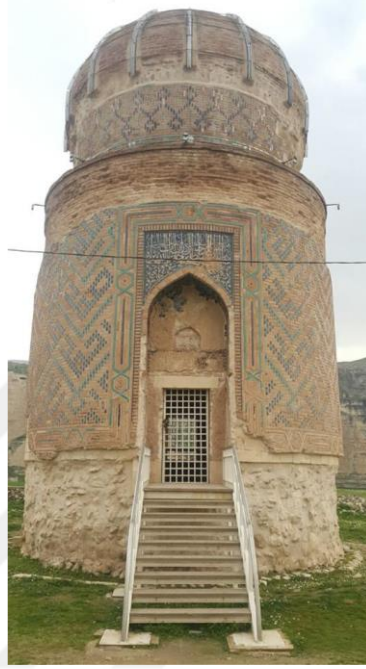
Şekil 15. Zeynelbey Türbesi (Körlü 2015)
