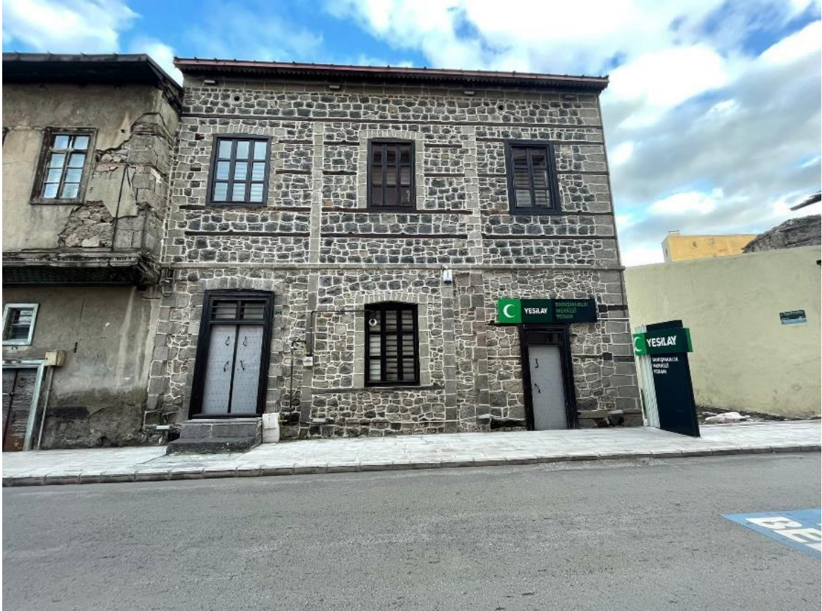
Şekil 46. Yeğenağa Sokak'ın cephe düzenlemesi yapılan Nezmi Turan Evi uygulama sonrası (Arşiv 3)
