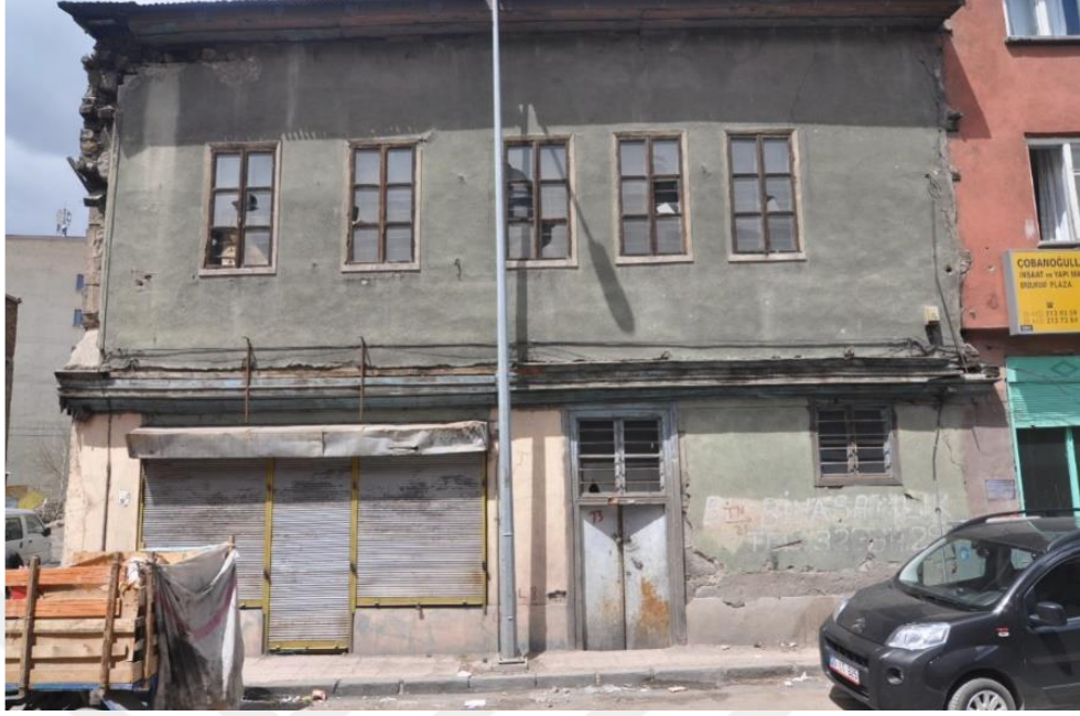
Şekil 39. Yeğenağa Sokak'ın cephe düzenlemesi yapılan Sedrettin Çobanoğlu Evi uygulama öncesi (Arşiv 1)
