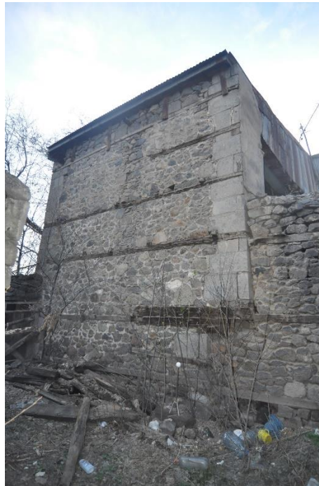
Şekil 42. Yeğenağa Sokak’ın cephe düzenlemesi yapılan Korucular Evi uygulama öncesi avlu görünüşü (Arşiv 1)
