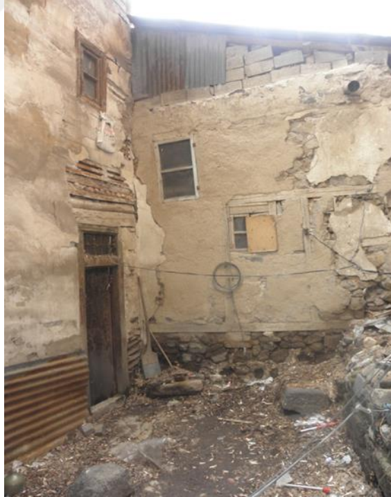
Şekil 48. Yeğenağa Sokak'ın cephe düzenlemesi yapılan yapı 4 uygulama öncesi avlu görünüşü (Arşiv 1)
