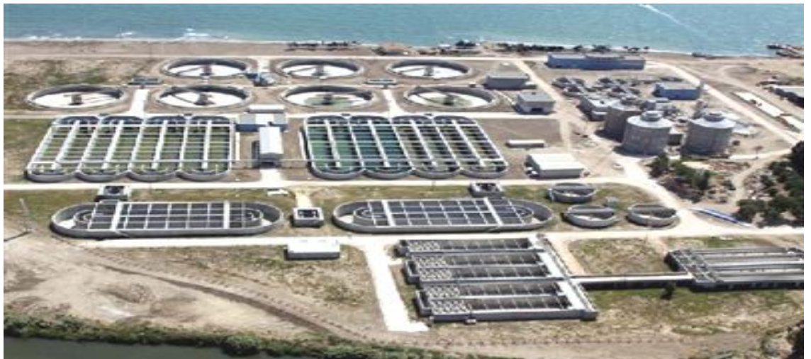
Şekil 3.5. Karaduvar atıksu arıtma tesisi
