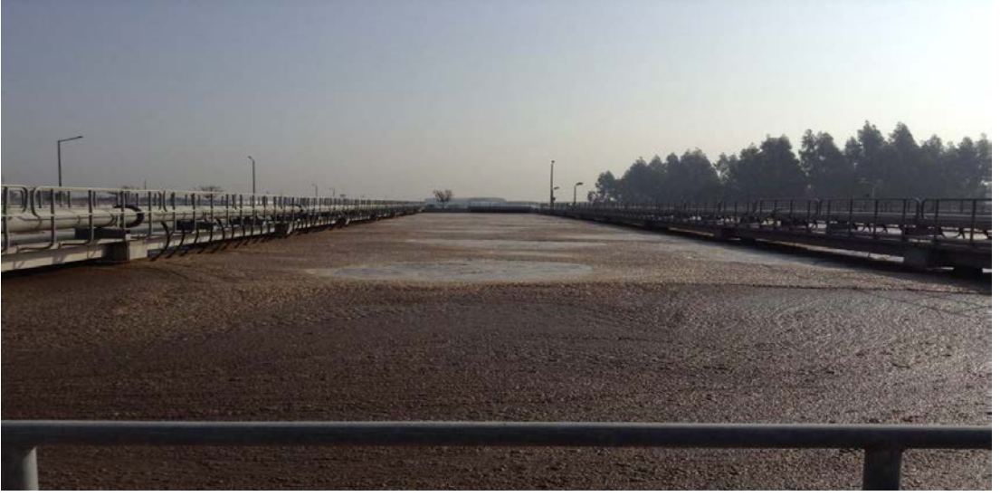
Şekil 3.6. Tarsus atıksu arıtma tesisi
