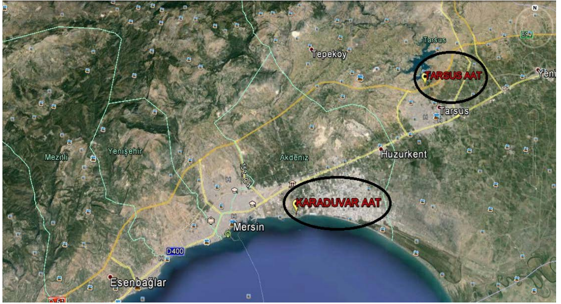
Şekil 3.4. Mersin ovasındaki atıksu arıtma tesisleri
