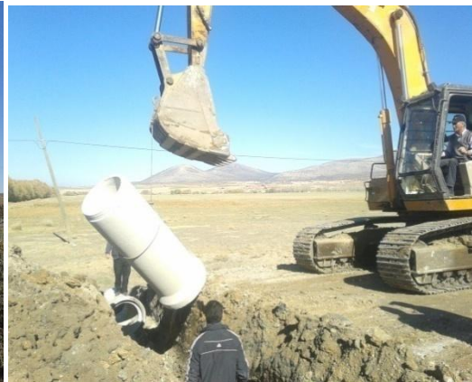
Şekil 3.28. Büz yerleştirilmesi
