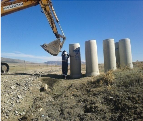
Şekil 3.27. Büz yerleştirilmesi
