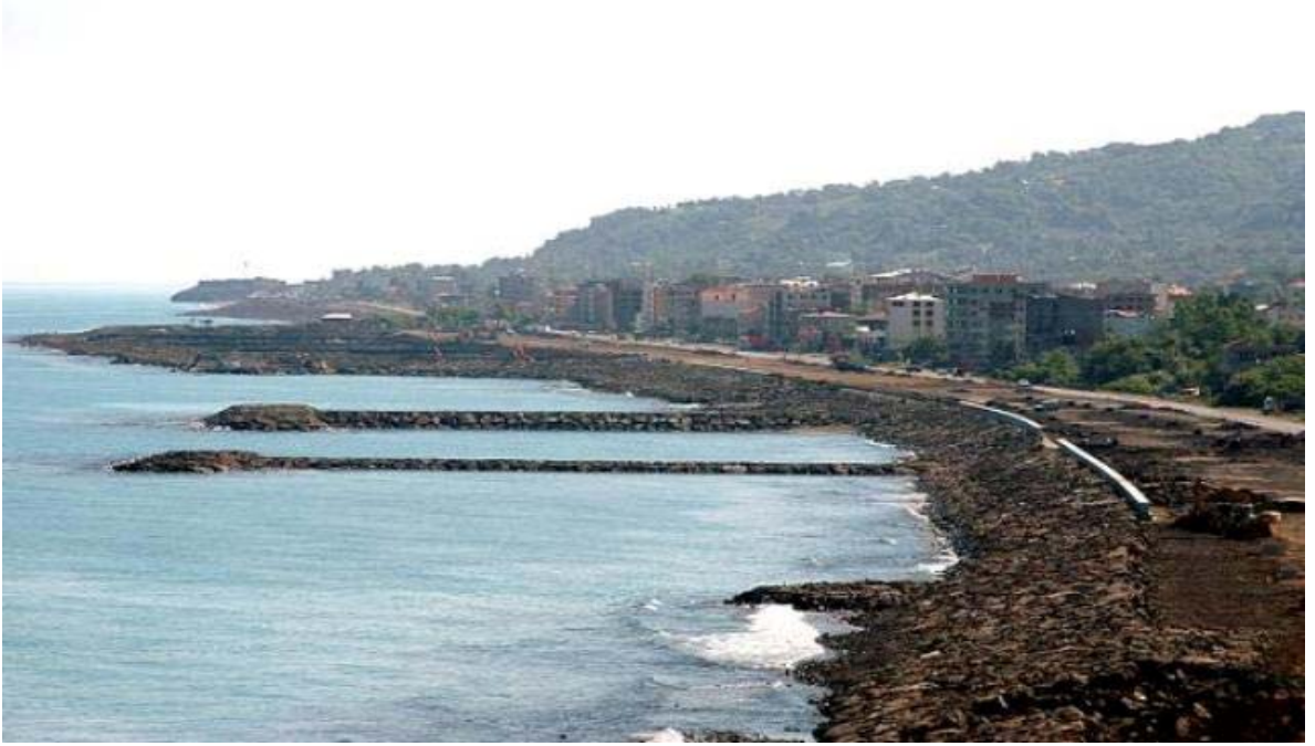
Fotoğraf 1.2 Karadeniz Sahil Yolu Yapımında Deniz Dolgusu Sonucu Doğal Yapısı Değişen Eynesil Kıyıları.
