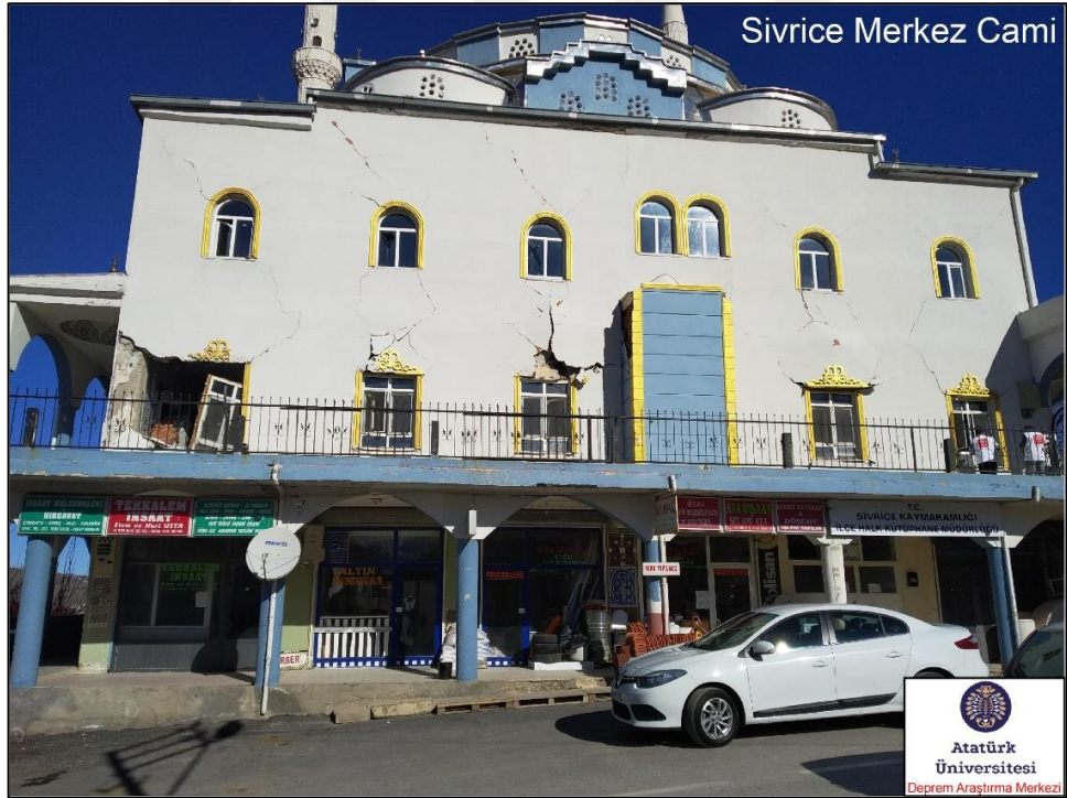
Şekil 14. Elazığ Sivrice Merkez Camiinde meydana gelen hasar (ATADAM, 2020)
