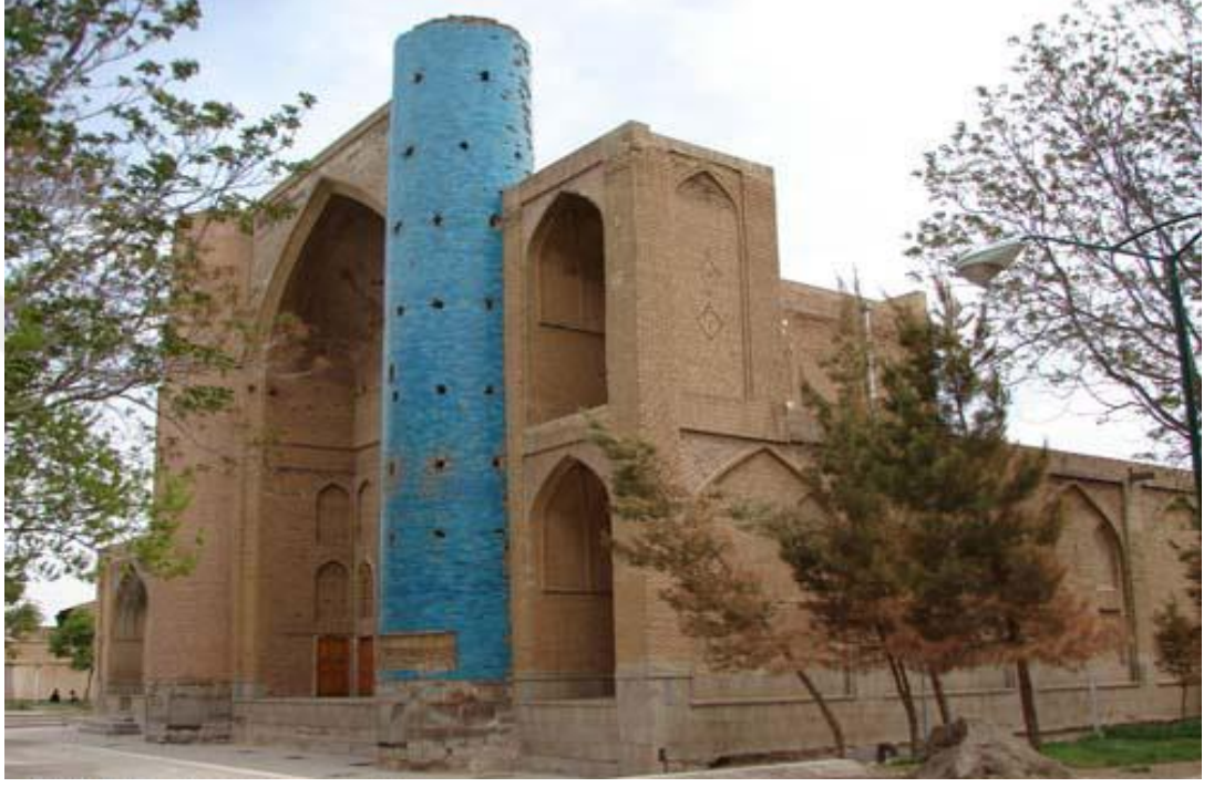
Fotoğraf 3.50. Şeykh Şehabeddin Eheri Türbesi muhtemelen Safevi döneminde yapılmıştır.
