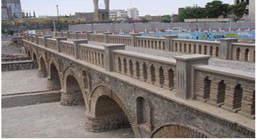
Fotoğraf 3.39. Tebriz şehrinde Mehran Rud Nehri üzerinde kurulmuş Garı köprüsü.
