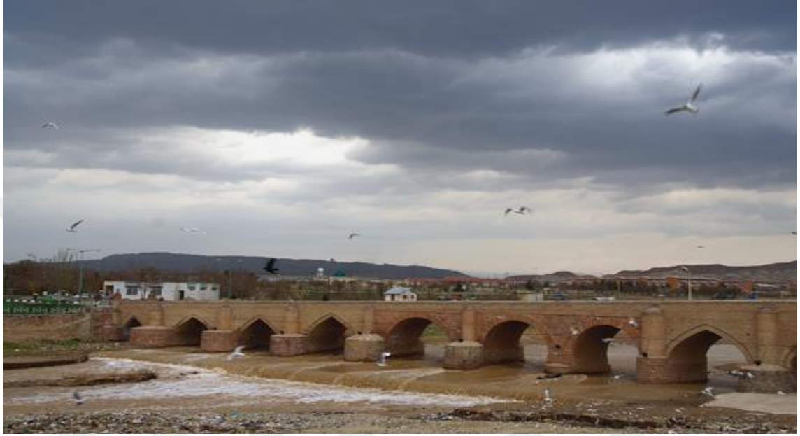
Fotoğraf 3.37. Acı Çay Köprüsü, 105 m uzunluğunda, 16 gözlü olarak inşa edilmiştir.
