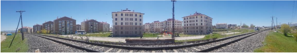
Şekil 54. Çalışma Alanı İçerisindeki Konutlar
