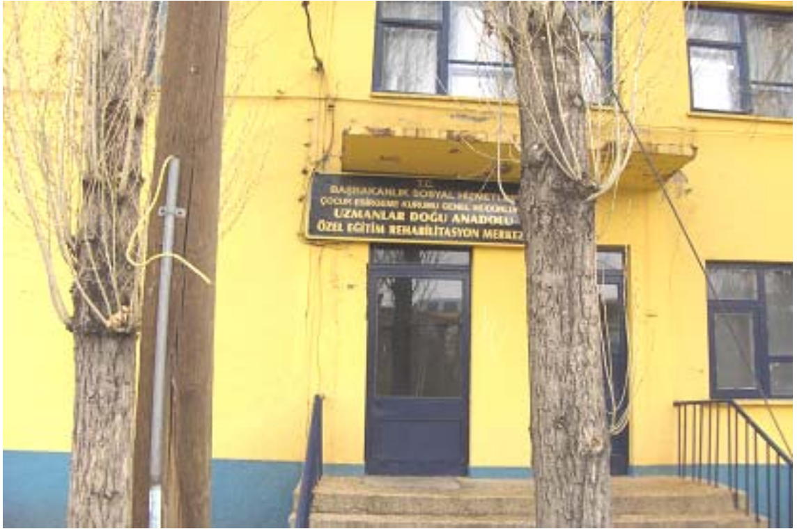
Şekil 4.11. Özel Uzmanlar Doğu Anadolu Özel Eğitim Ve Rehabilitasyon Merkezi-2 girişi
