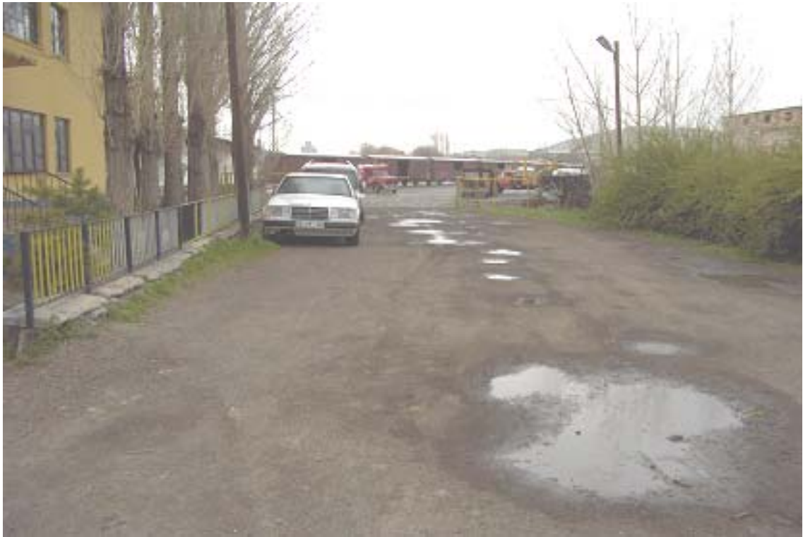
Şekil 4.14. Özel Uzmanlar Doğu Anadolu Özel Eğitim Ve Rehabilitasyon Merkezi-2 otopark alanı
