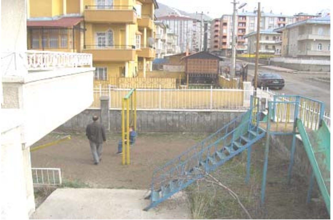
Şekil 4.9. Özel Uzmanlar Doğu Anadolu Özel Eğitim ve Rehabilitasyon Merkezi bahçesi
