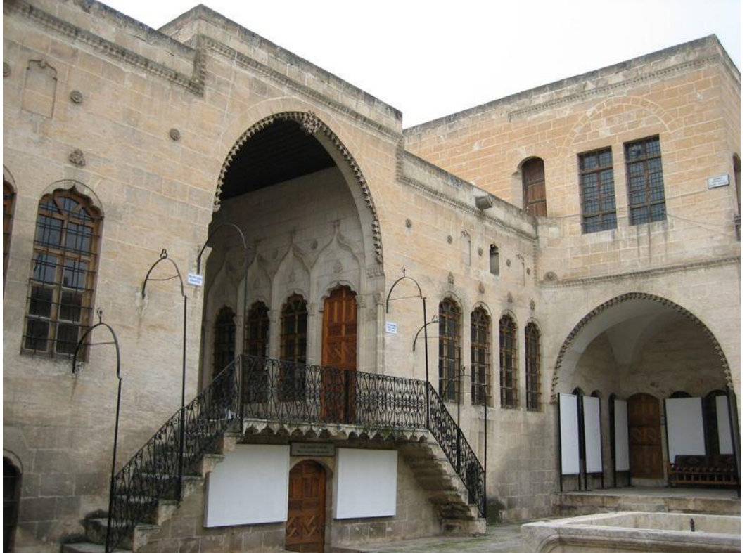
Fotoğraf 3.84. Hacı Hafızlar Evi, günümüzde Kültür Varlıklarını Koruma Bölge Müdürlüğü binası olarak kullanılmaktadır ( http://www.urfakultur.gov.tr ).
