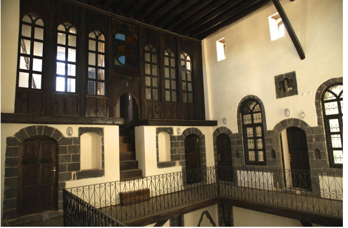
Fotoğraf 3.93. Terziler Evi, düzgün kesilmiş bazalt taşlardan iki katlı olarak inşa edilmiştir.
