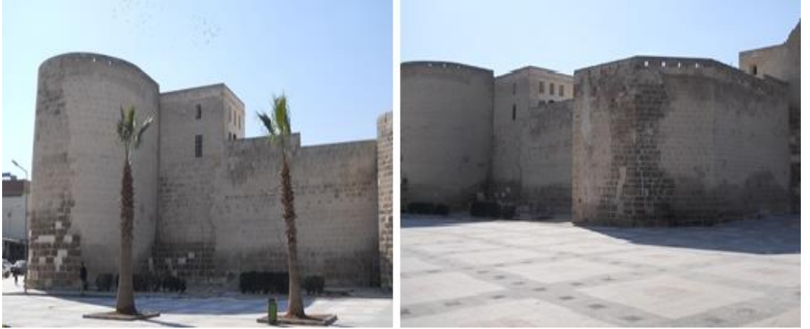
Fotoğraf 3.59. Mahmudoğlu Kulesi, Şanlıurfa şehir surlarının doğu yönünde inşa edilmiştir.
