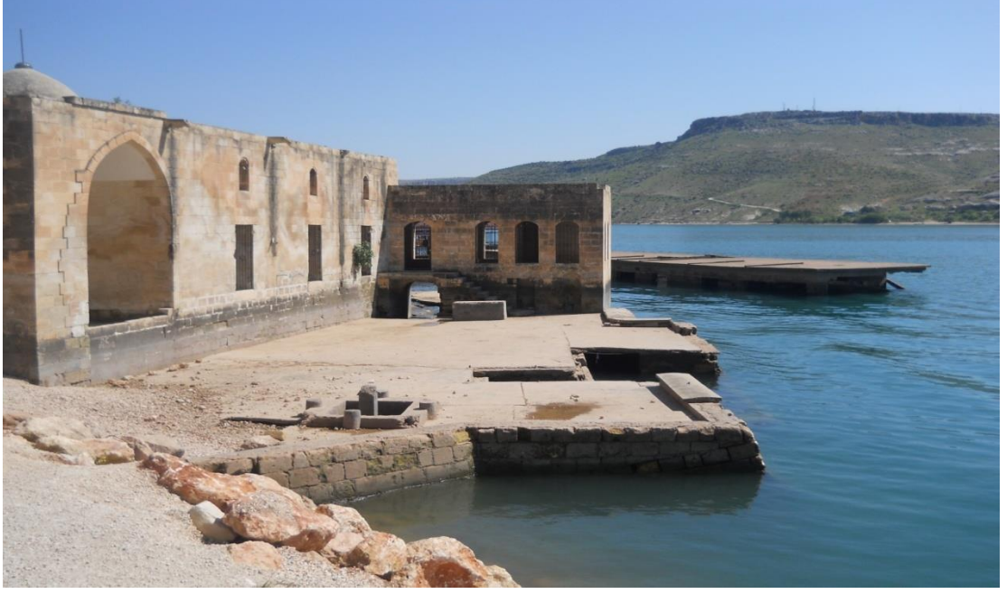
Fotoğraf 3.49. Halfeti’de bir bölümü sular altında kalan Merkez Camii.
