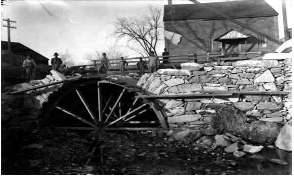
Şekil 2.2. Taş köprü yapım aşaması (Anonymous 2013d)
