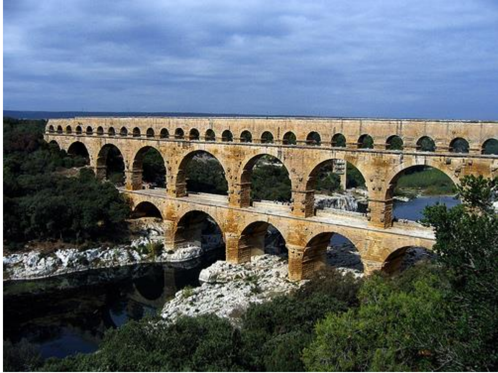
Şekil 2.5. Gard köprüsü (Anonymous 2013c )
