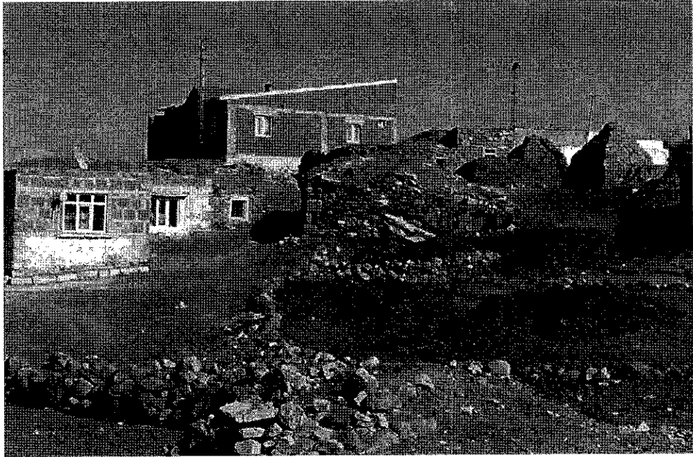
Fotoğraf 2.6. Köy Meskenlerinde Geleneksel Yapı Malzemesi Kullanılmakla Beraber Son Yapılan Meskenlerde Tuğla Duvar, Beton Direk ve Galvenize Sac Örtü Kullanılmaktadır.
