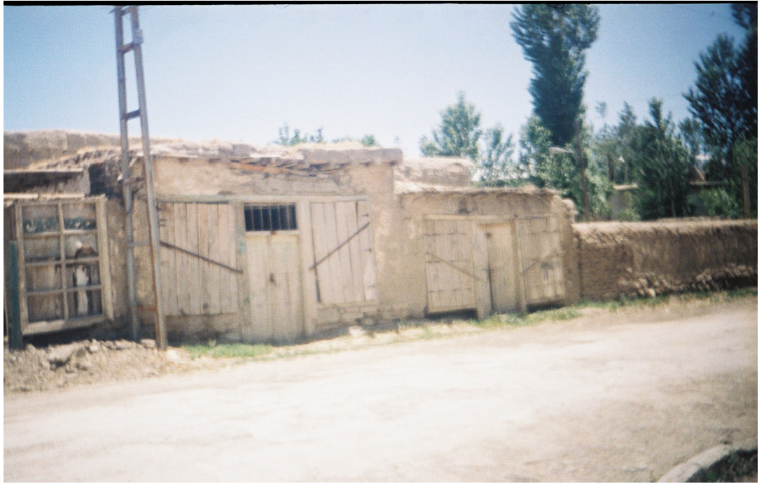
Fotoğraf 2.4. Gürpınar kasabasında, çarşının Kiğzi mahallesinden Cumhuriyet mahallesine doğru kaymasıyla, buradaki dükkânlar yıkılmaya yüz tutmuştur.
