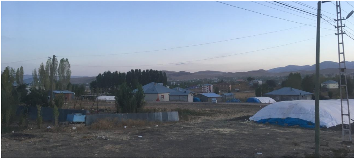
Fotoğraf 2.4. Zafer Mahallesi'nin Kuzeyinde Bulunan Tek Katlı Yapılardan Bir Görünüm.
