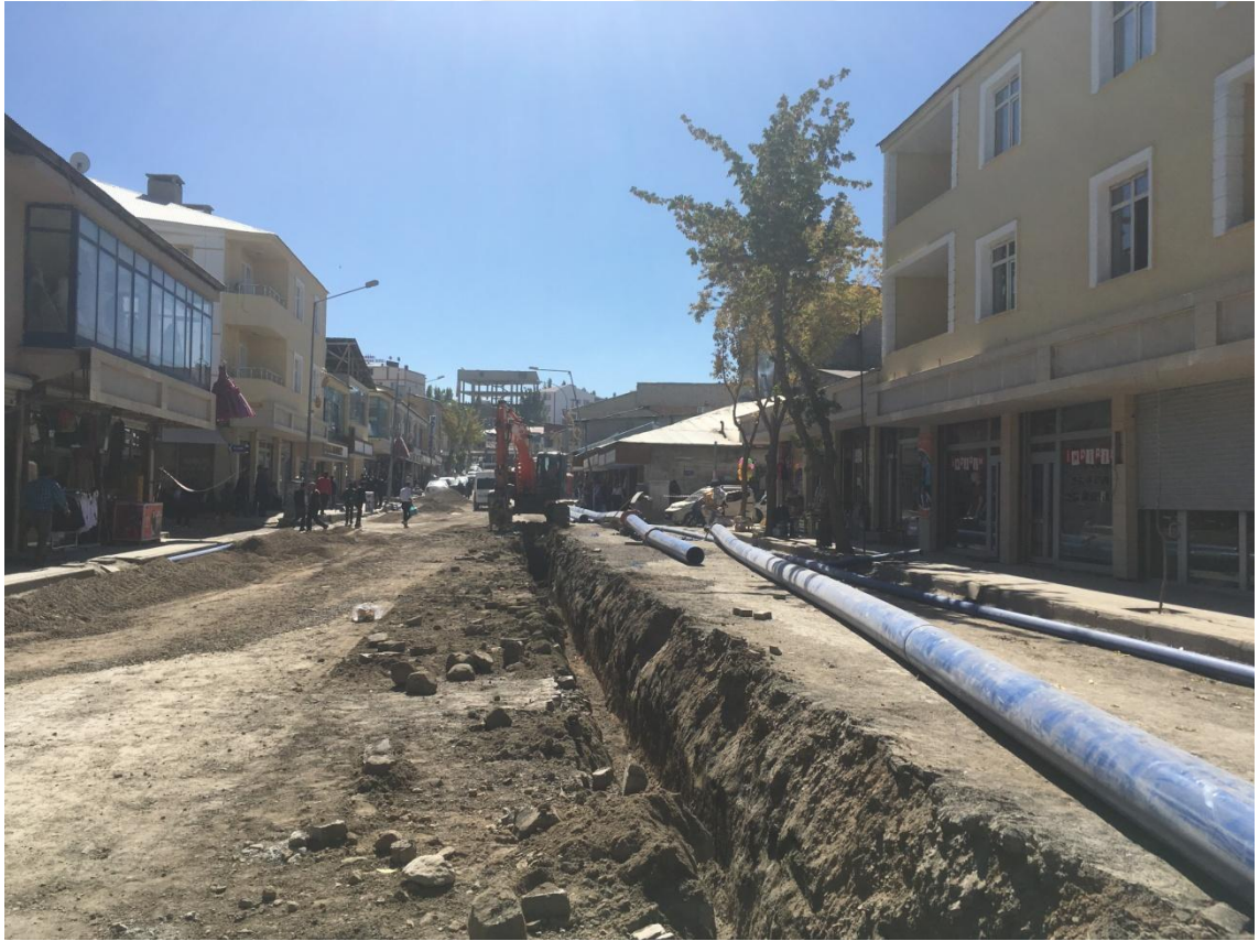
Fotoğraf 4.1. Özgürlük Caddesi'nde Devam Etmekte Olan Altyapı Çalışmalarından Bir Görünüm.
