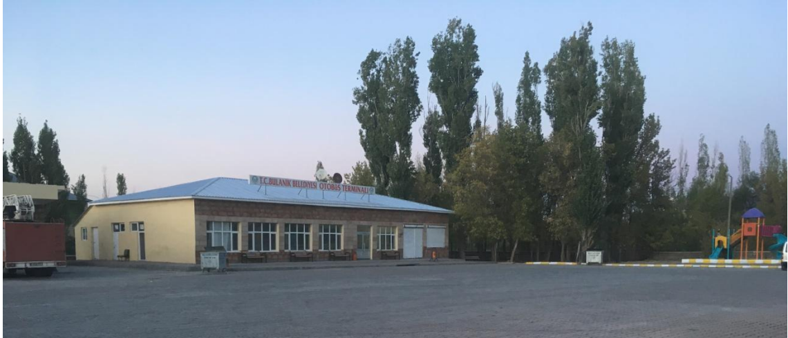
Fotoğraf 2.14. Bahçelievler Mahallesi'nde Bulunan Şehirlerarası Otobüs Terminalinden Bir Görünüm
