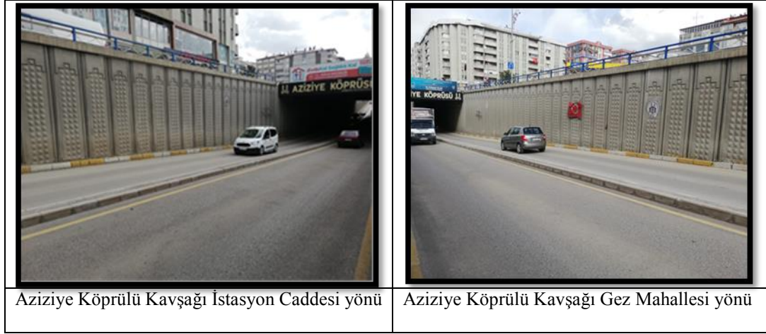
Şekil 30. Aziziye Köprüsü Kavşağı Mevcut Durum Görüntüleri-2
