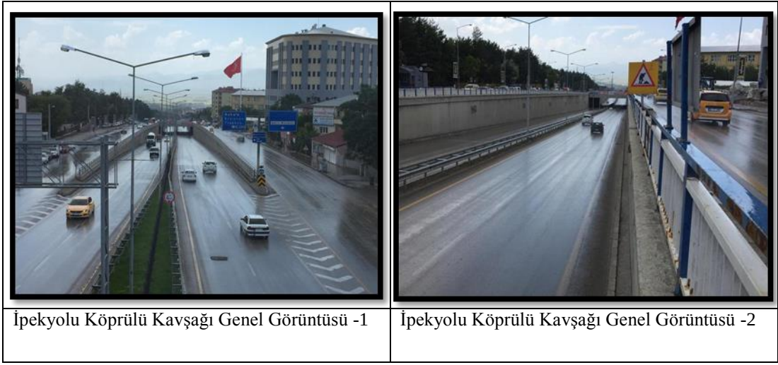
Şekil 39. İpekyolu Köprülü Kavşağı mevcut durum görselleri
