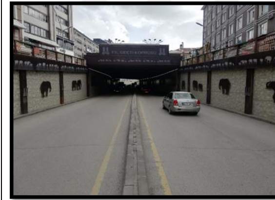
Fil Geçti KöprülÜ Kavşağı Çaykara Caddesi yönü
