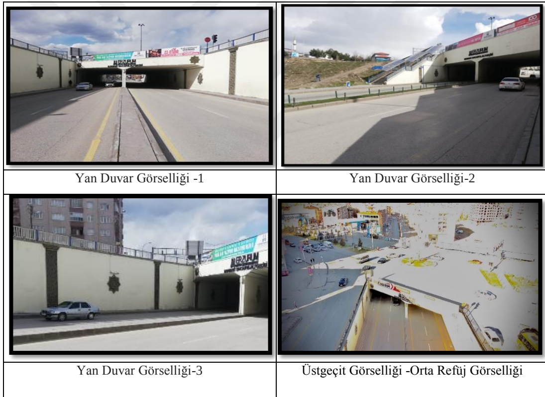
Şekil 119. M. Durak Sakarya Köprüsü Kavşağı (K7)
