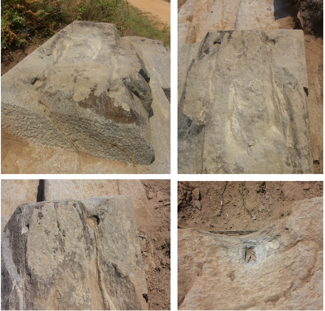
Resim 61. Eğridere Kybele Açık hava Tapınım Alanındaki Kenet Yuvaları
