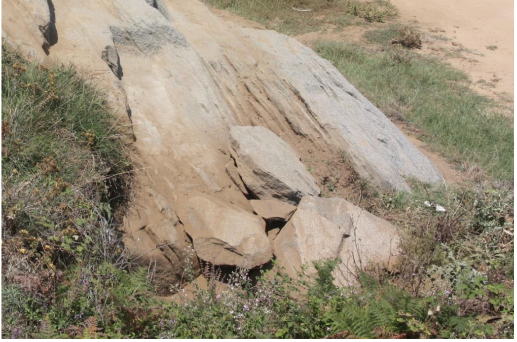
Resim 59. Açık hava Tapınım Alanının Doğu Tarafındaki Tahribat
