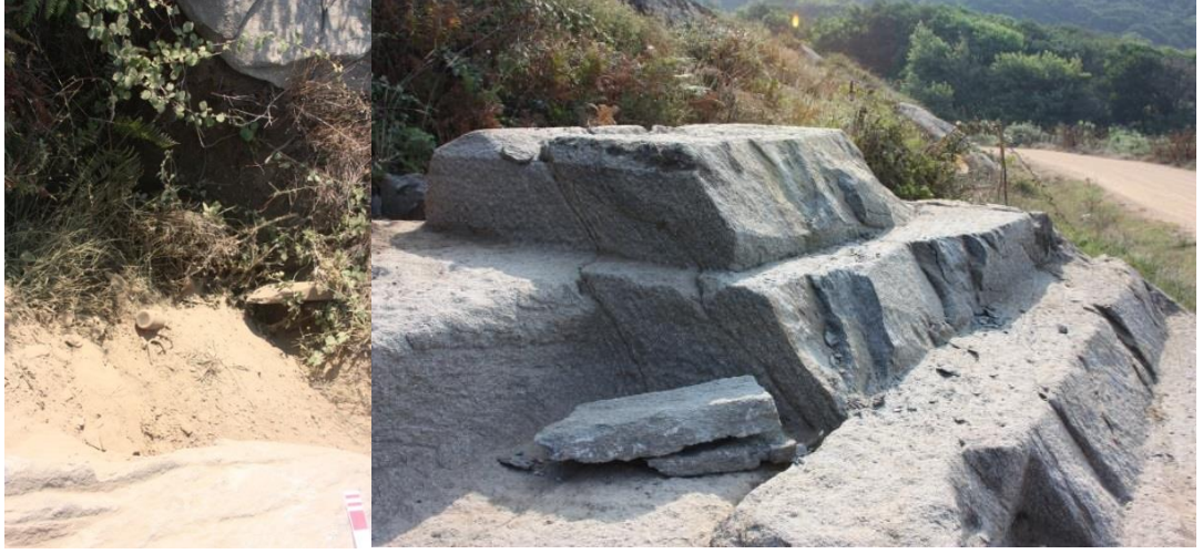
Resim 62. Egridere Kybele Açık hava Tapınım Alanındaki Tahribat İzleri
