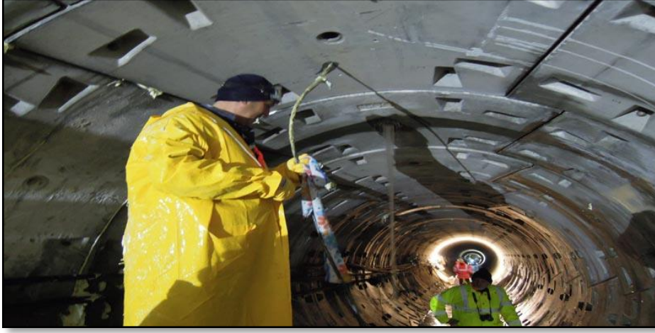
Şekil 4. Tünellerde enjeksiyon uygulaması (Anonim a)
