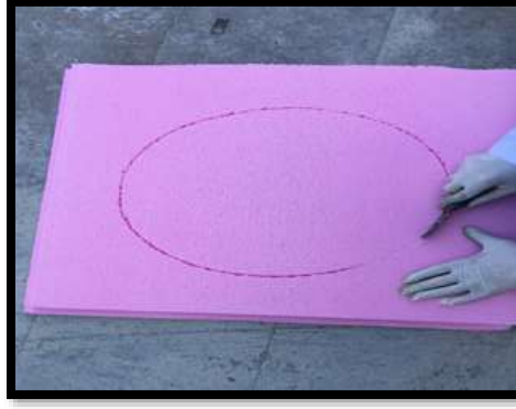
Şekil 8. Sızdırmazlık için kullanılan foamboard levha
