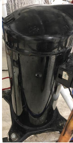
Şekil 8. Copeland marka scroll özellikli kompresör
