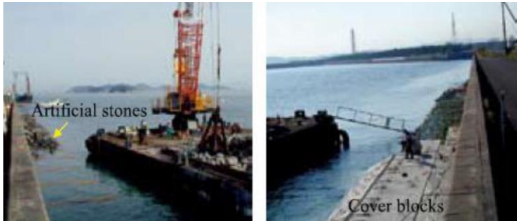
Şekil 24. Çelik cürufunun dolgu malzemesi olarak kullanımı (Yılmaz 2018)
