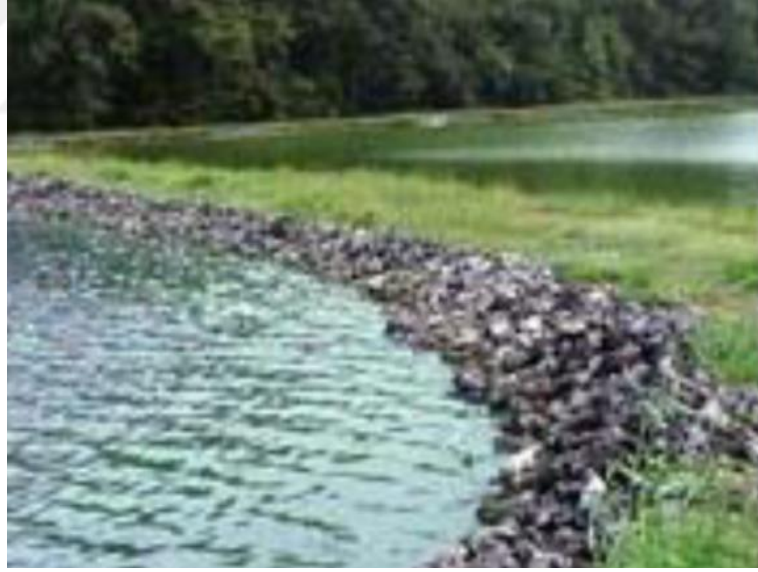
Şekil 26. Kıyı erozyonuna karşı eao cürufunun kullanımı (NSA 2011)
