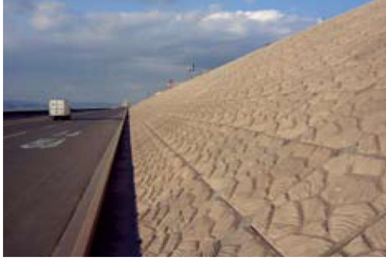
Şekil 25. Japonya’da ferroform kullanılarak yapılan deniz duvarı (TÇÜD 2015)
