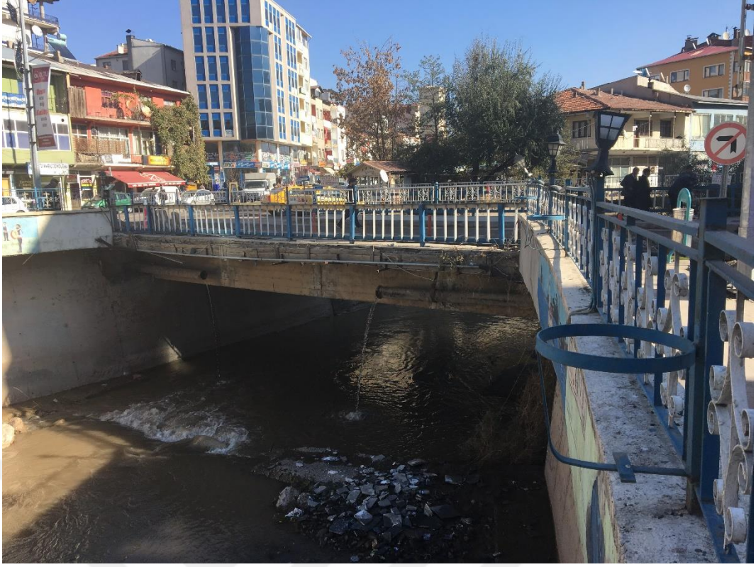
Şekil 14. Oltu Çayı ve Üzerindeki Köprü-3
