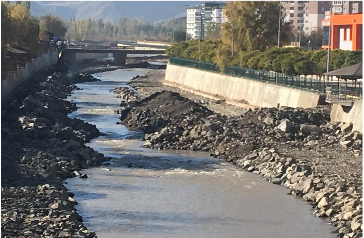
Şekil 11. Oltu Çayı ve Üzerindeki Köprü-1
