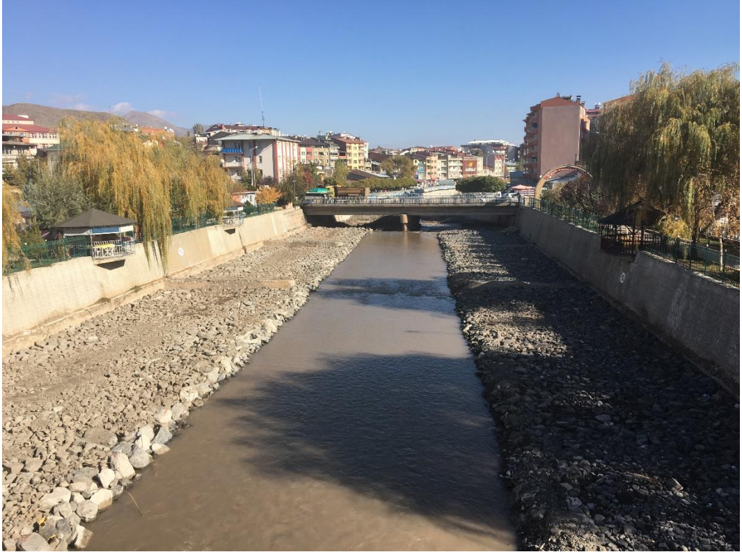
Şekil 13. Oltu Çayı ve Üzerindeki Köprü-2
