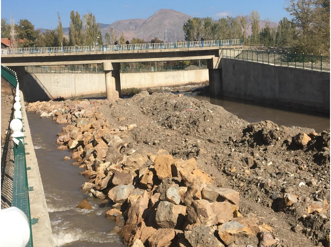
Şekil 17. Oltu Çayı ve Üzerindeki Köprü-6
