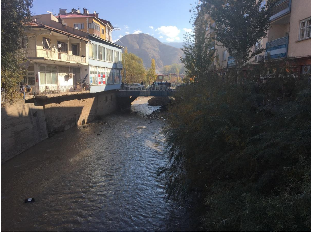
Şekil 15. Oltu Çayı ve Üzerindeki Köprü-4
