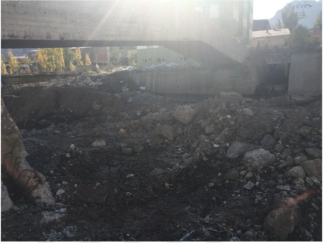
Şekil 16. Oltu Çayı ve Üzerindeki Köprü-5
