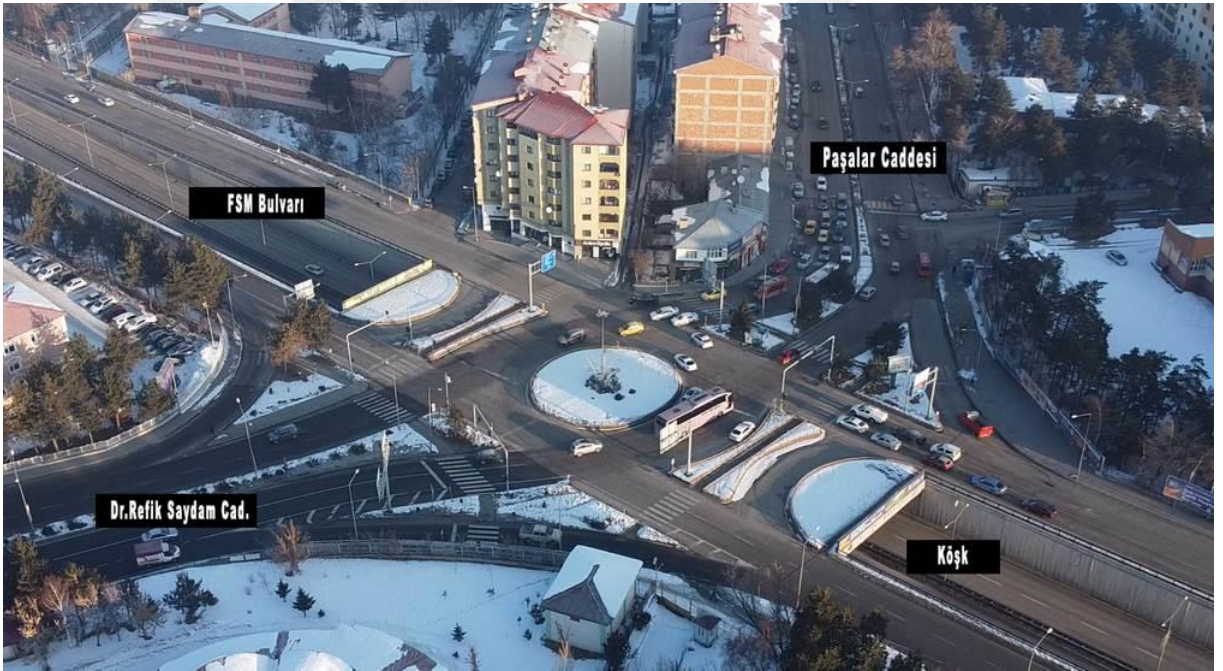
Şekil 23. Çat Yolu Kavşağı İHA görüntüsü
