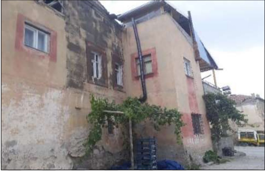
Fotoğraf 2.5. Araştırma Sahasında Yığma Tekniği İle Yapılmış Olan Bir Konut Görüntüsü.
