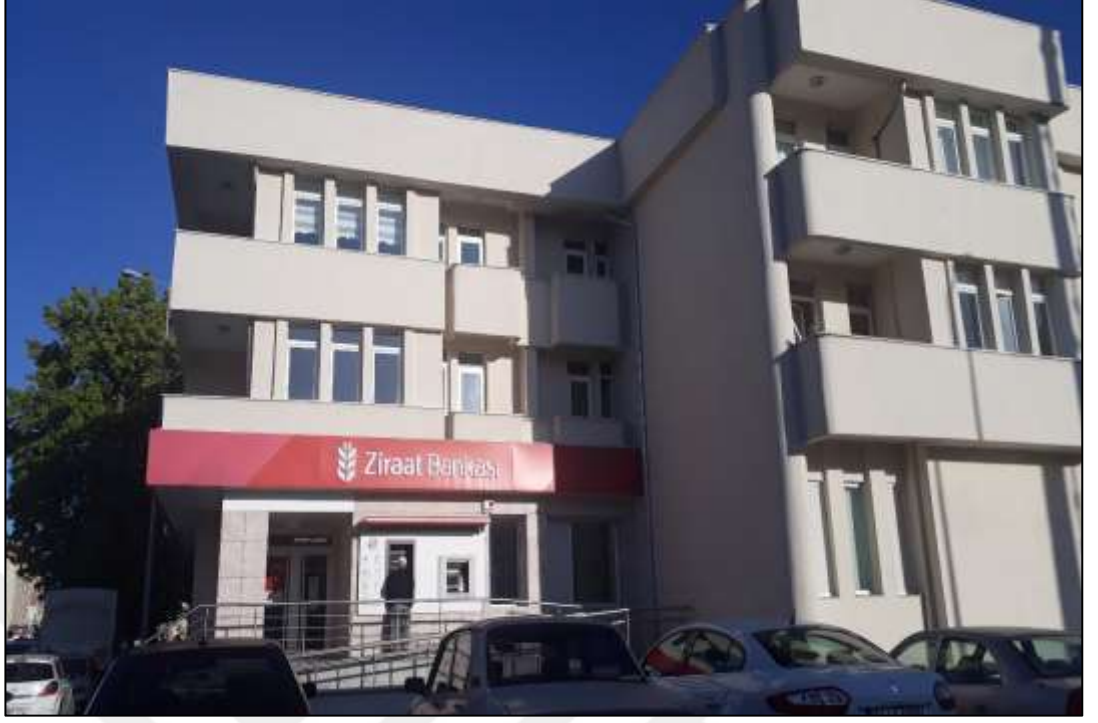
Fotoğraf 3.4. Araştırma Sahasında Yer Alan Bankadan Bir Görünüm.
