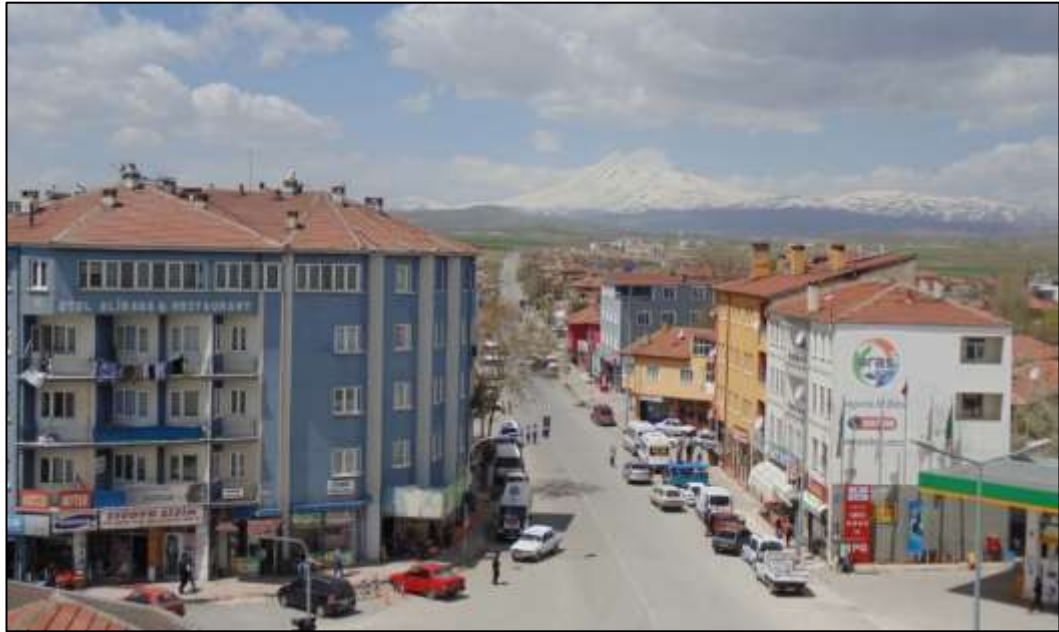
Fotoğraf 2.6. Araştırma Sahasındaki Betonarme Konutlardan Bir Görünüm.
