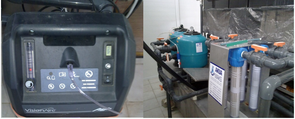
Şekil 3.2. Oksijen jeneratörü, biyolojik ve mekanik filtreler
