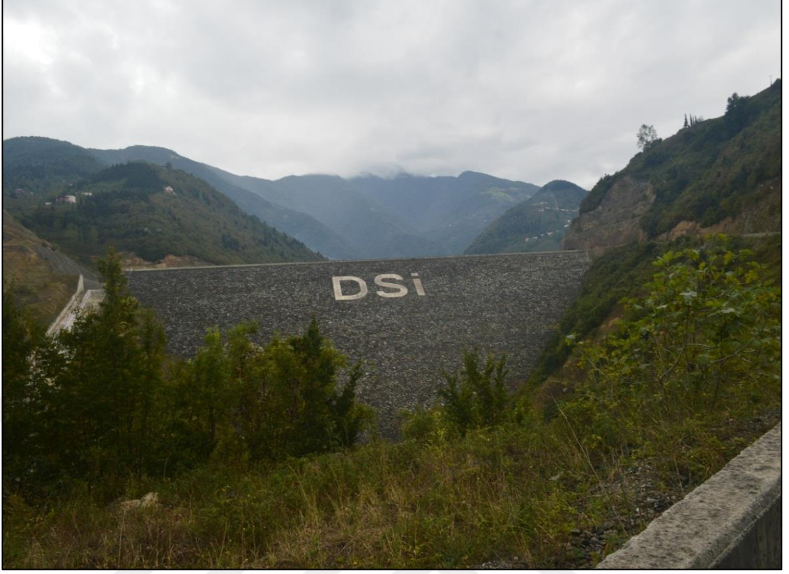
Fotoğraf 1.2. Atasu Barajı ön yüzü beton kaplama yöntemi ile inşa edilmiştir.
