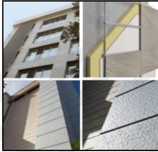
Şekil 78. Seramik ve Güçlendirilmiş doğal taş desenli levha kaplama örneği
