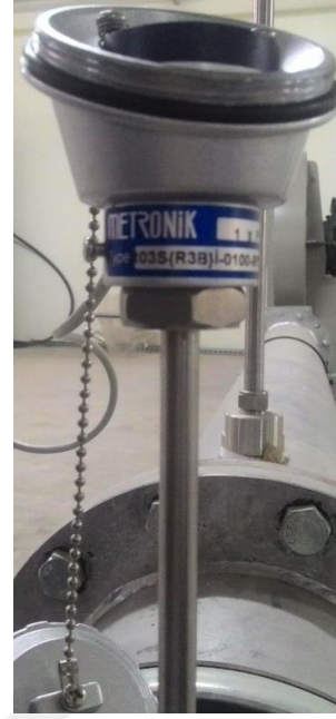
Şekil 3.2. Basınç transmitteri (solda), sıcaklık sensörü (sağda)
