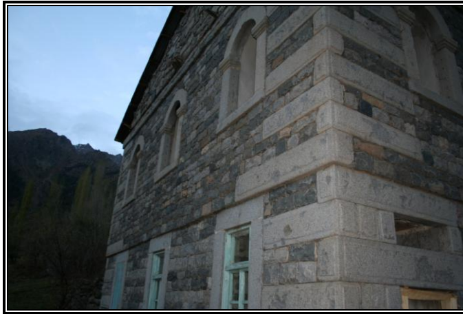
Şekil 4. 28. Sırakonaklar Köyünde yöresel mimariden görünüm
