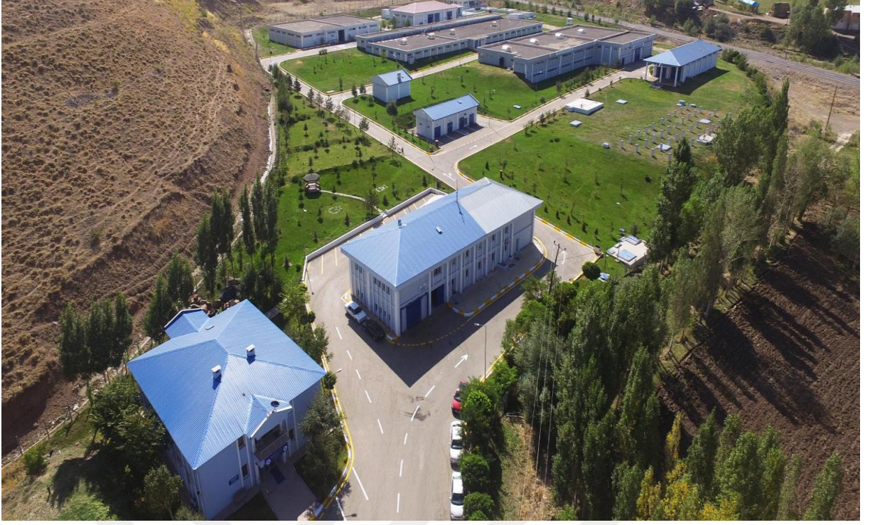
Şekil 5. İçme suyu arıtma tesisine ait genel görünüm
