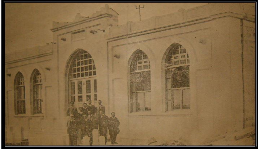
F.6: Yeni yapılan Malatya Türk Ocağı Binası
