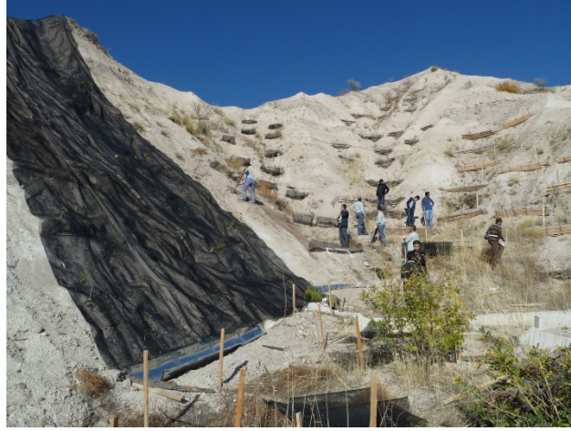
Şekil 3.11. Geonet uygulaması
