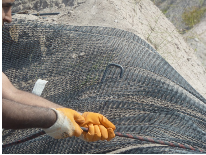
Şekil 3.9. Ankraj çubuklarının yerleştirilmesi
