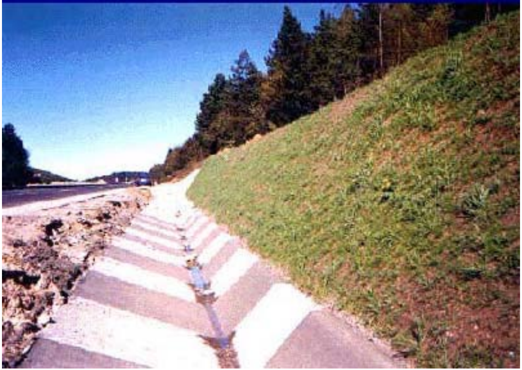
Şekil 2.30. Ankara – İstanbul yolu bolu dağı geçişi, geomat ile erozyon kontrolü sağlanması çalışma sonrası (Erbil 2009)
