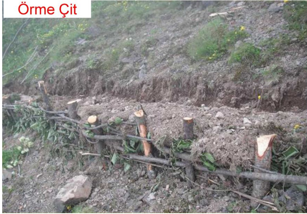
Şekil 2.2. Örne çit tesisi örneği (Anonim 2013a)
