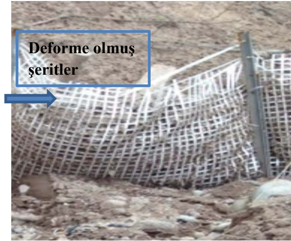
Şekil 4.3. Çelik tel takviyeli geogrid eşik uygulaması
