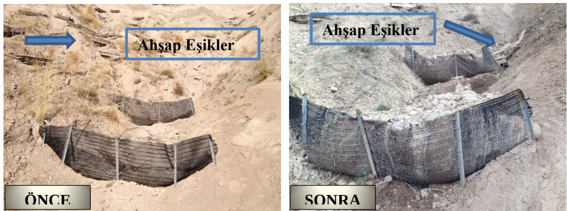
Şekil 4.2. Çelik tel takviyeli geonet eşik uygulaması
