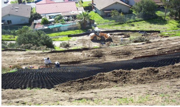
Şekil 2.44. Geocell şev uygulaması örneği (Anonim 2013k)
