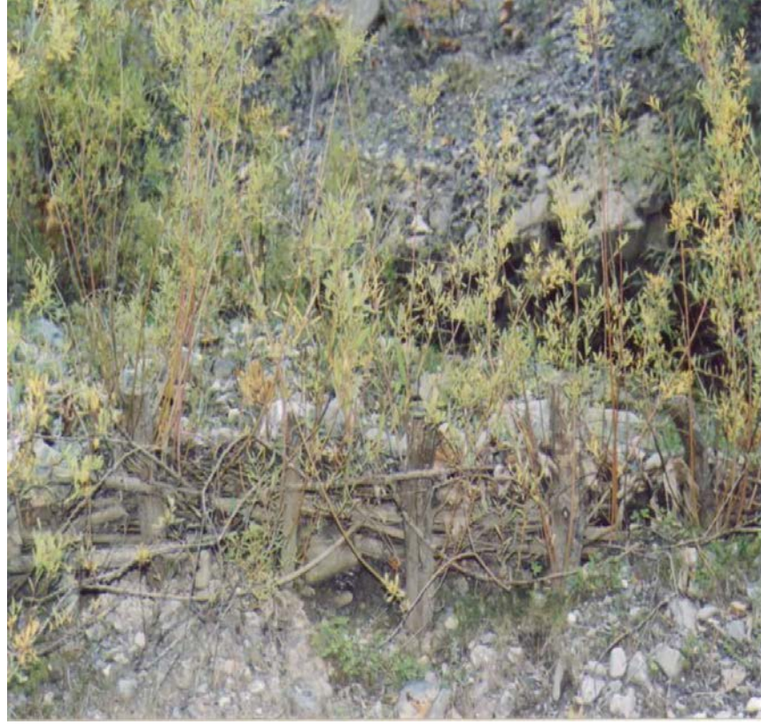
Şekil 2.3. Çalı demetli çit tesisi örneği (Anonim 2013a)
