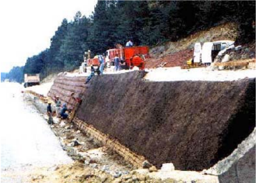
Şekil 2.29. Ankara – İstanbul yolu Bolu Dağı geçişi, geomat ile erozyon kontrolü Sağlanması-İmalat aşaması örneği (Erbil 2009)
