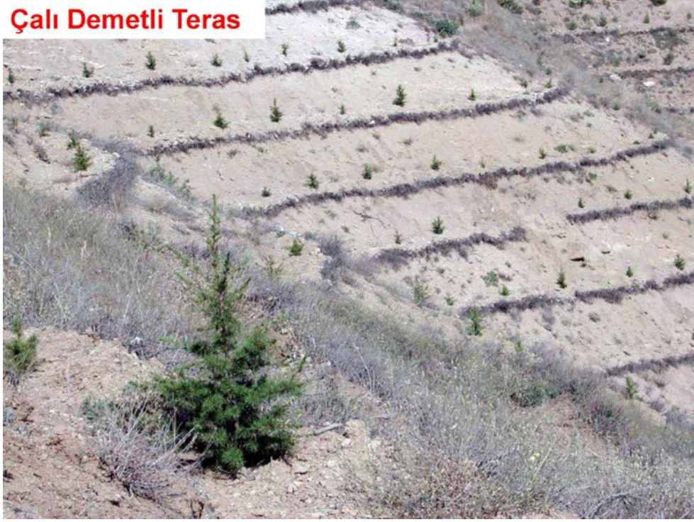
Şekil 2.4. Çalı demetli teras örneği (Anonim 2013a)
