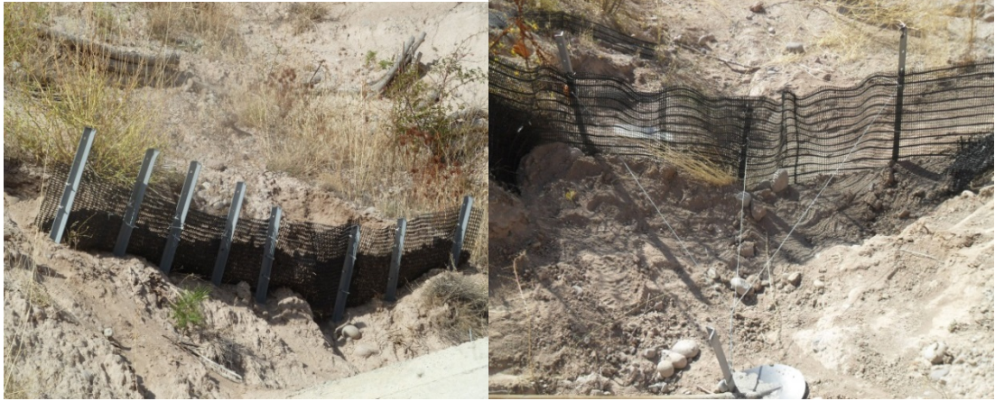
Şekil 3.6. Çelik tel takviyeli geonet eşik uygulamaları
