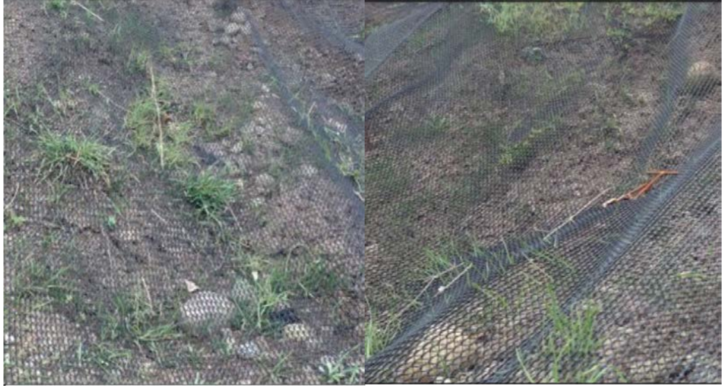
Şekil 4.1. Geonet altında çimlenmenin başlaması
