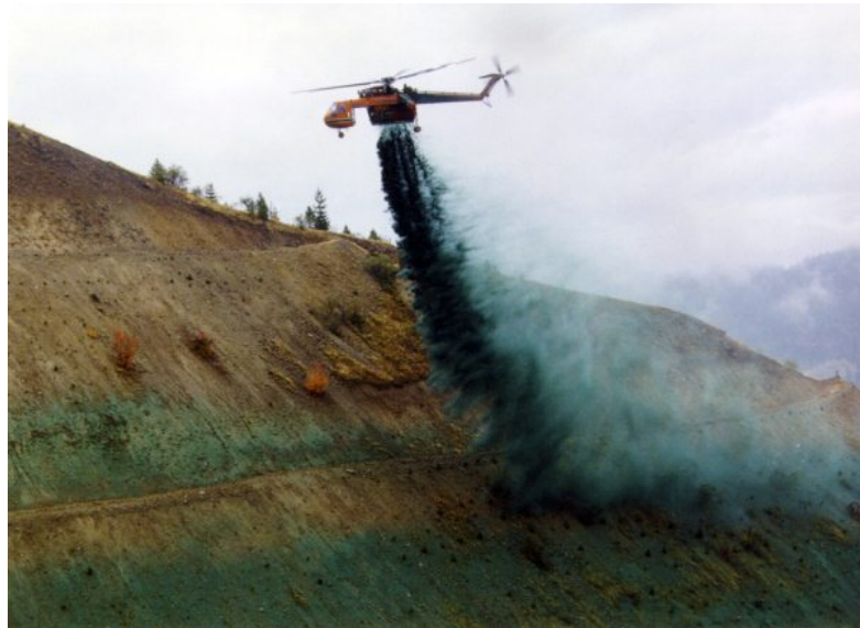
Şekil 2.10. Şevde hydroseeding uygulaması (Anonymous 2013h)
