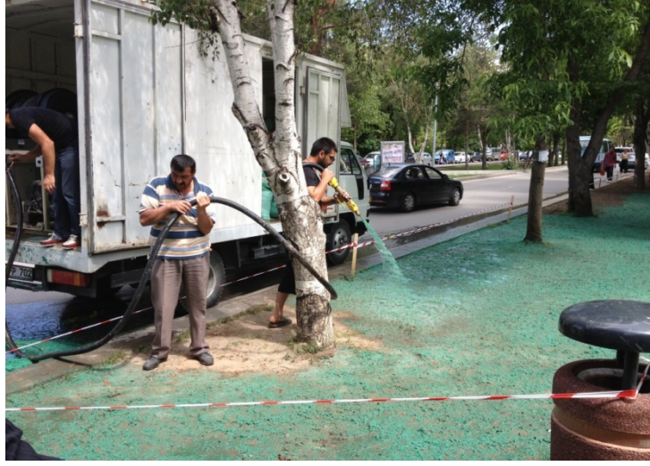
Şekil 2.9. Atatürk Üniversitesi yerleşke içi hydroseeding uygulaması
