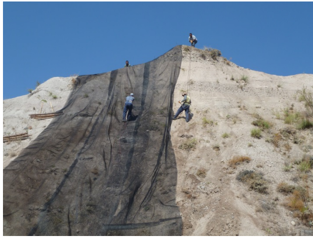
Şekil 3.8. Geonet ürünü uygulama aşamasından bir görünüm
